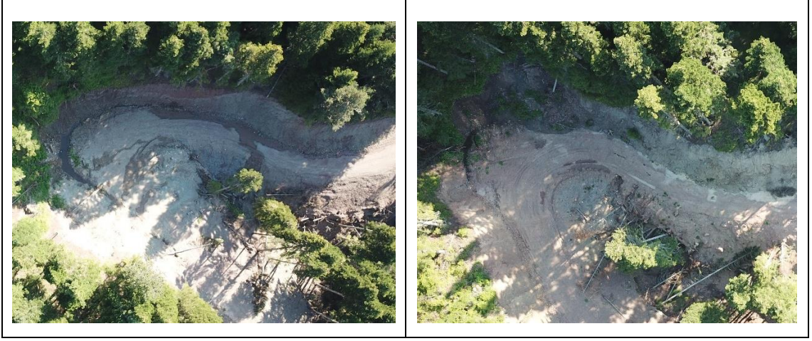
Şekil 3.1. Enine drenaj yapısı inşa edilmeyen kesişim noktası (solda) ve dik açılan kazı şevinde meydana gelen göçme (sağda).
