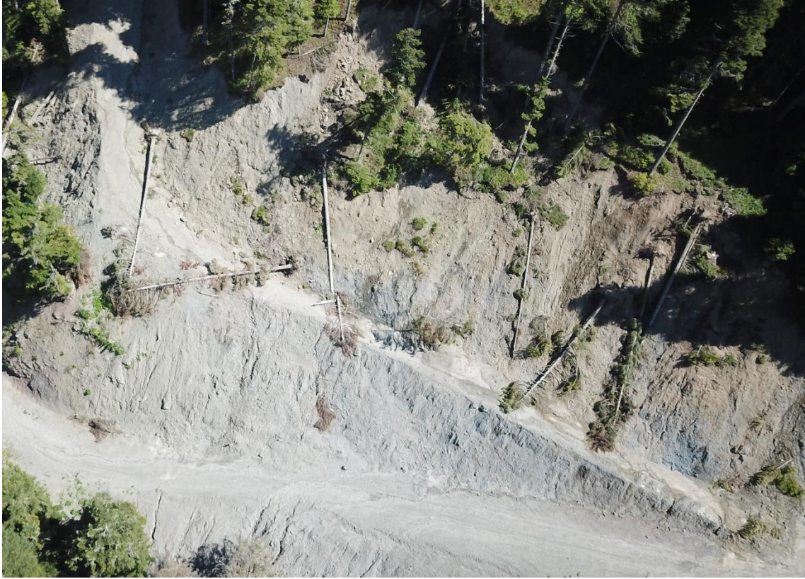
Şekil 3.5. Kazı şevi eğiminin standartlara göre daha dik verilmesi sonucu meydana gelen göçme.
