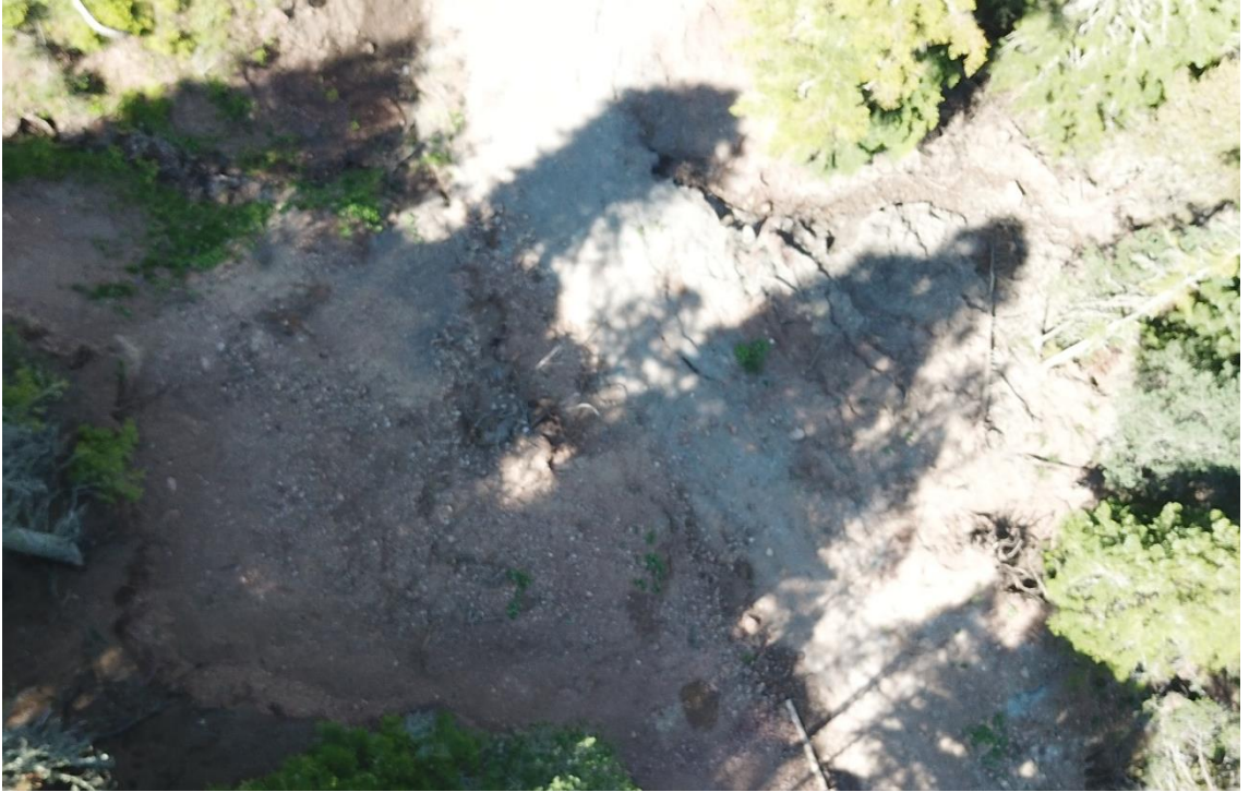
Şekil 3.4. Dere yatağı düzenlenmemiş, enine drenaj yapısı tesis edilmiş dere-yol kesişimi ve meydana gelen göçme.
