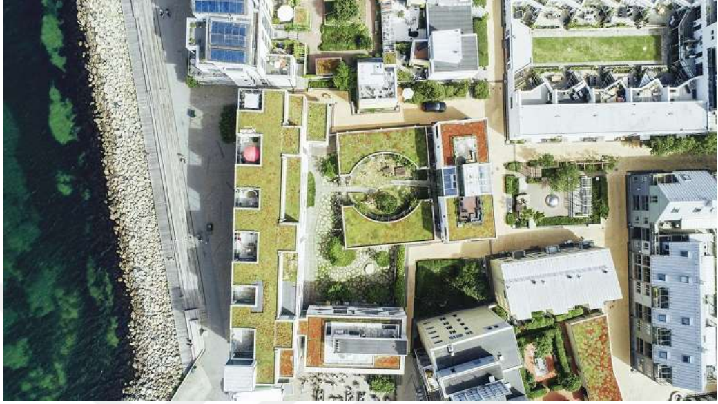
Şekil 2.63. Västra Hamnen, Malmö Çatı Bahçeleri (Url-92)
