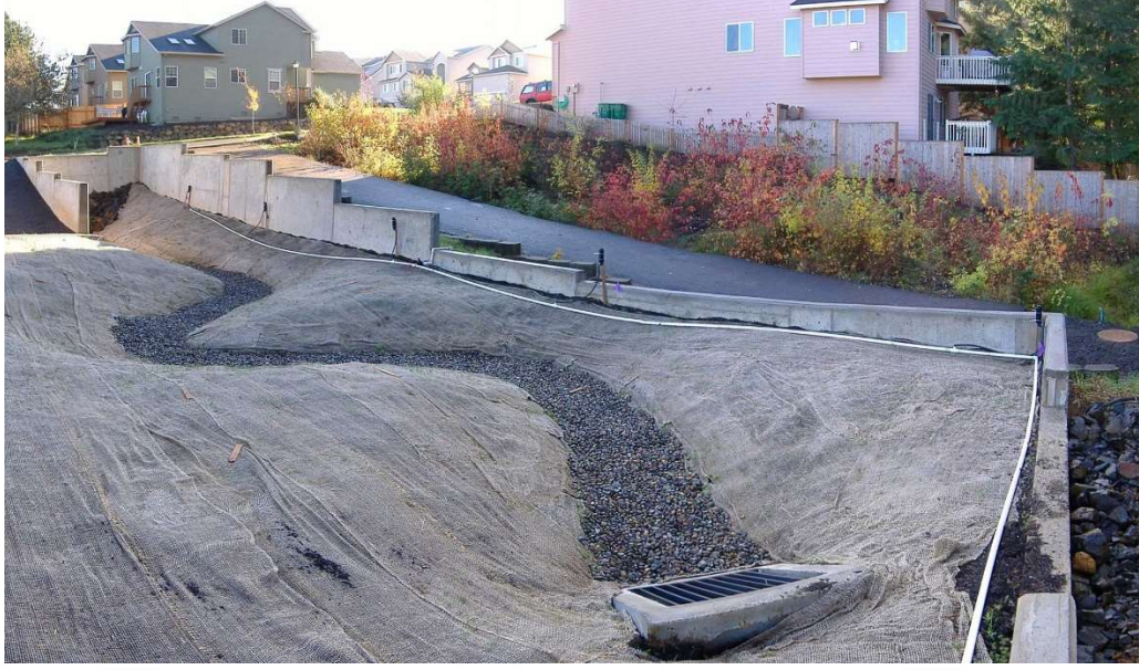
Şekil 1.31. Yapım aşamasında kıvrımlı bir biyolojik hendek (Url-21)
