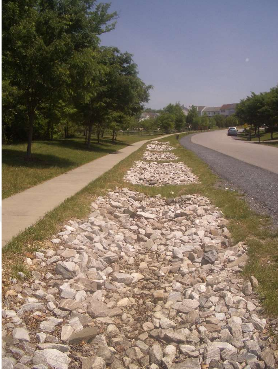
Şekil 1.35. Yol kenarı infiltrasyon hendeği örneği (Url-23)
