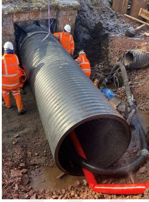
Şekil 1.42. Yeraltı Drenaj ve Kanalizasyon boruları (Url-28)
