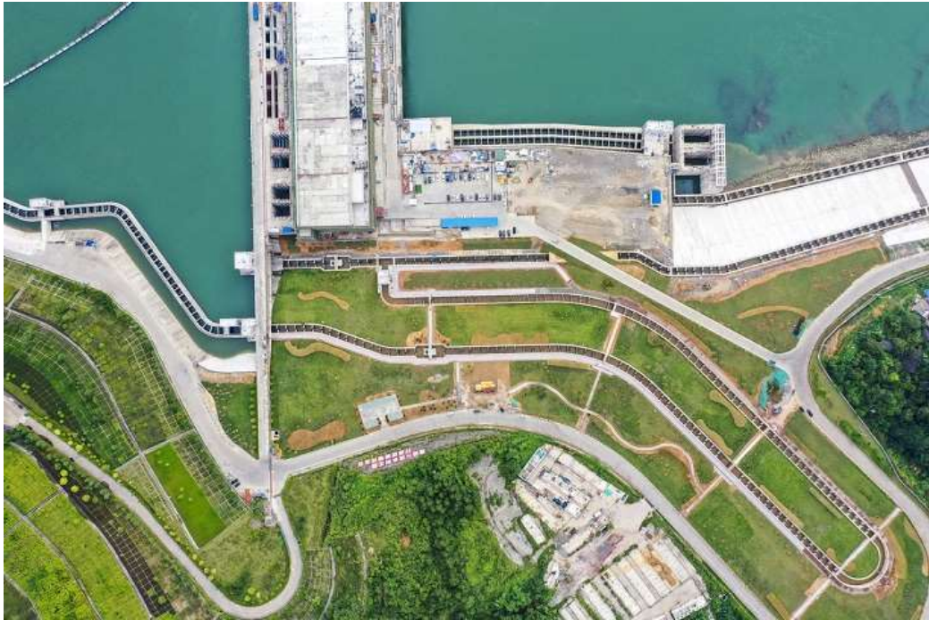
Şekil 2.18. Güneybatı Çin'deki Datengxia su kaynakları yönetim tesisi (MWR, 2023)
