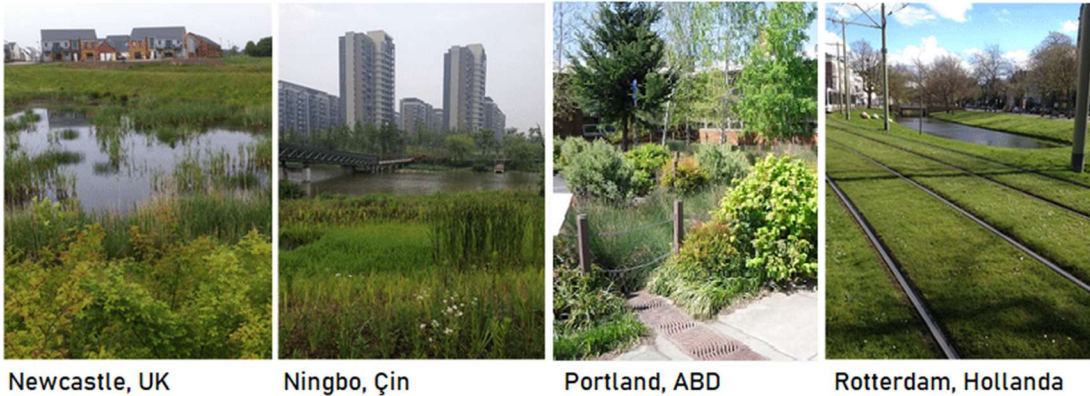
Şekil 2.7. Dünya'dan Mavi-Yeşil Altyapı örnekleri, Newcastle'da sürdürülebilir drenaj göleti, Ningbo Eko-koridoru, Portland'da gölete bağlanan bir yağmur bahçesi ve Rotterdam'da yeşil tramvay yolları (Url-61)
