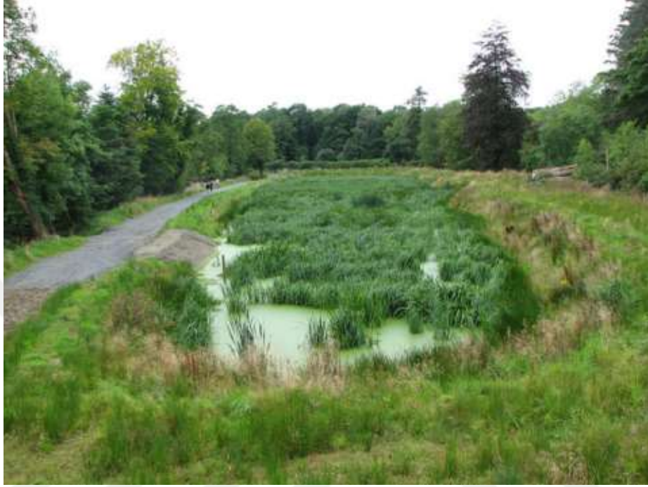
Şekil 2.22. İskoçya'dan Kırsal Sürdürülebilir Drenaj Sistemi olarak yapay sulak alan haline getirilmiş bir yeşil alan (SEPA, 2024)
