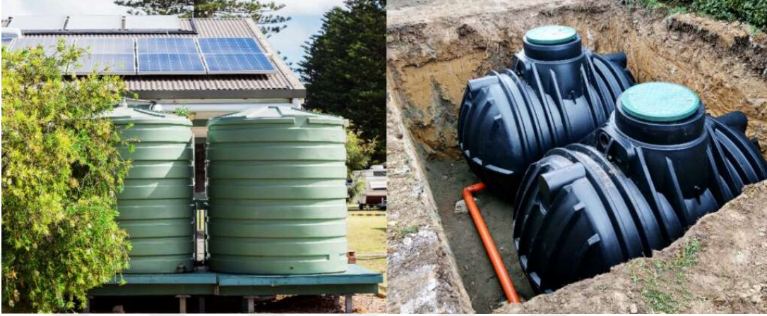
Şekil 1.60. Yağmur suyu depoları yeraltına da yerleştirilebilmektedir (Url-41)
