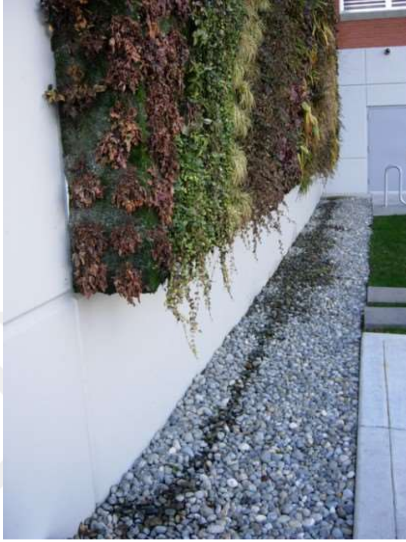
Şekil 1.36. Dikey bahçe altında bir infiltrasyon hendeği (Url-24)
