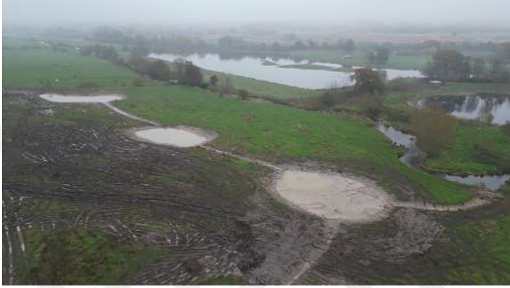
Şekil 2.15. Blythe Nehri güzergahında taşkın yönetimi için yeni sulak alanlar oluşturulması süreci, İngiltere (TVW, 2023)
