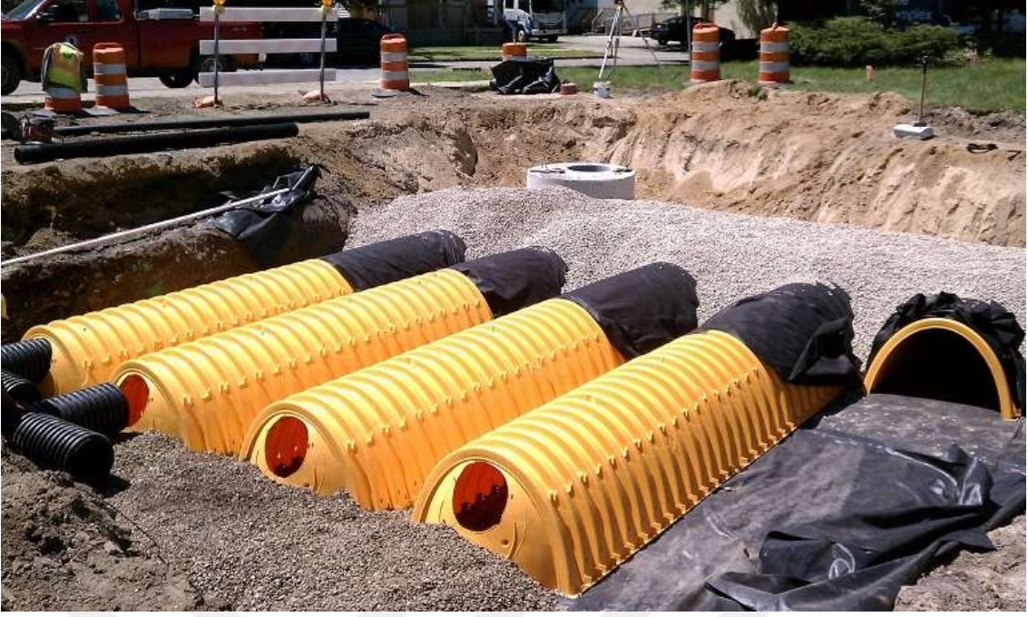
Şekil 1.80. Bir otoparkın altına kurulan bir yüzey altı su tutma sistemi (Url-54)
