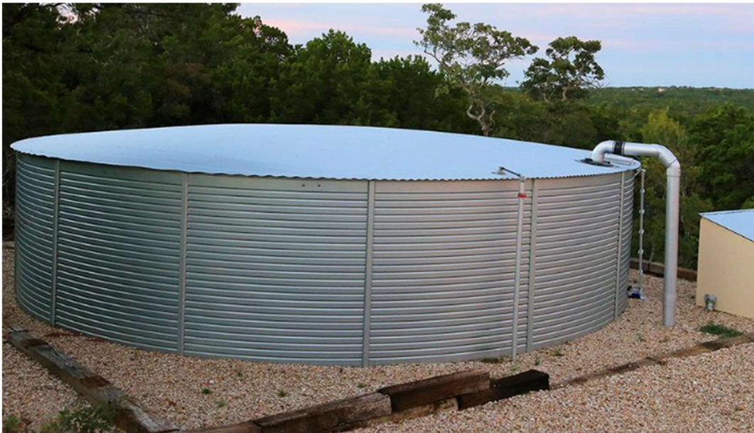
Şekil 1.61. Avusturalya'dan kurak bölgelerde büyük önem taşıyan yüksek kapasiteli yağmur suyu deposu (Url-42)
