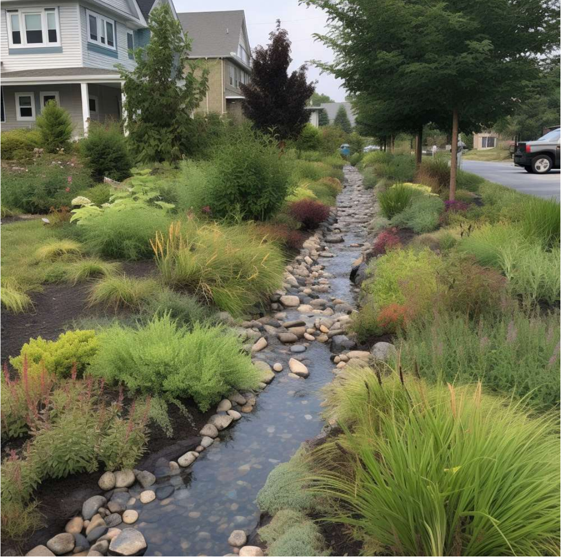
Şekil 1.30. Eğimli bir sokak boyu uzanan bir biyolojik hendek (Waterborne Environmental, 2023)
