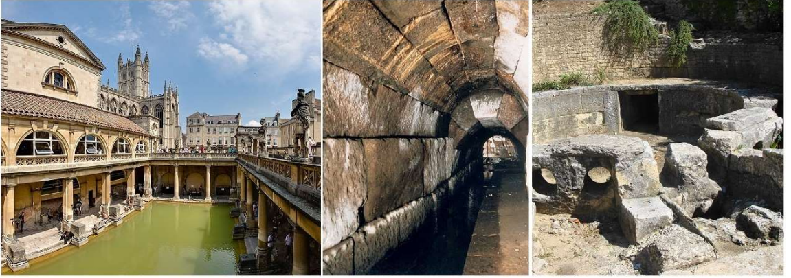
Şekil 1.10. Roma Hamamı (Thermae), Kanalizasyon sistemi (Cloaca Maxima) ve içme suyunu toplayıp şehirlere dağıtan Castellum aquae (Url-7, Url-8)
