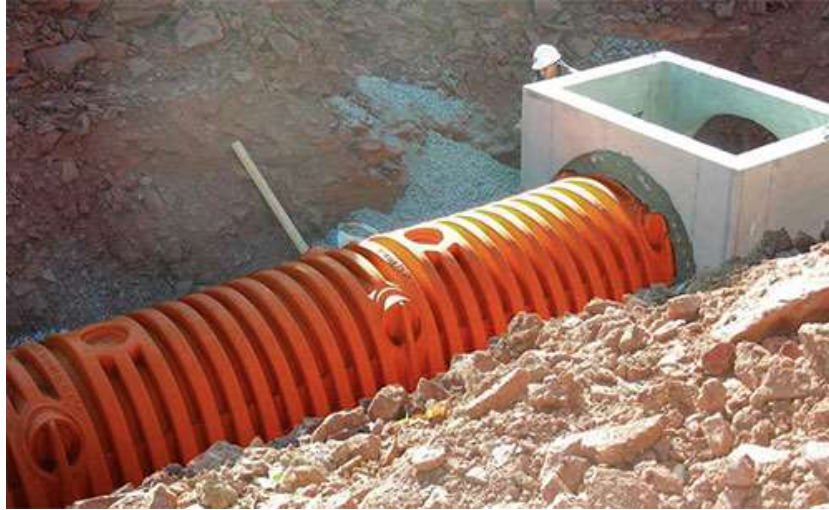
Şekil 1.43. Suyu hem taşıyıp hem geçici depolayabilen hazne sistemleri (Url-29)
