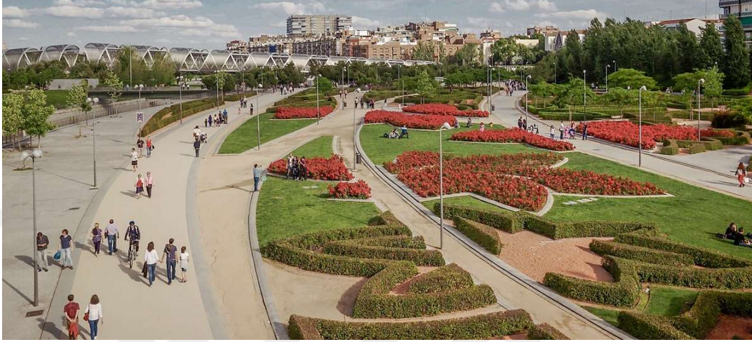
Şekil 2.59. Madrid'de bulunan Rio parkı otoyolun parka çevrilmesiyle oluşturulmuş aşırı yağışlar sırasında kontrollü taşıyabilen bir parktır (Url-88)
