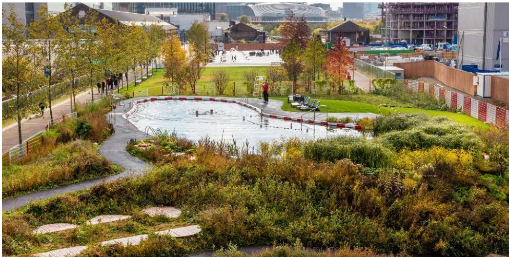
Şekil 2.46. King's Cross Pond Club'da Su, bitkiler ve doğal filtrelemeyi desteklemek için bir dizi filtre kullanılarak doğal süreçlerle arıtılır (OOZE, 2024)
