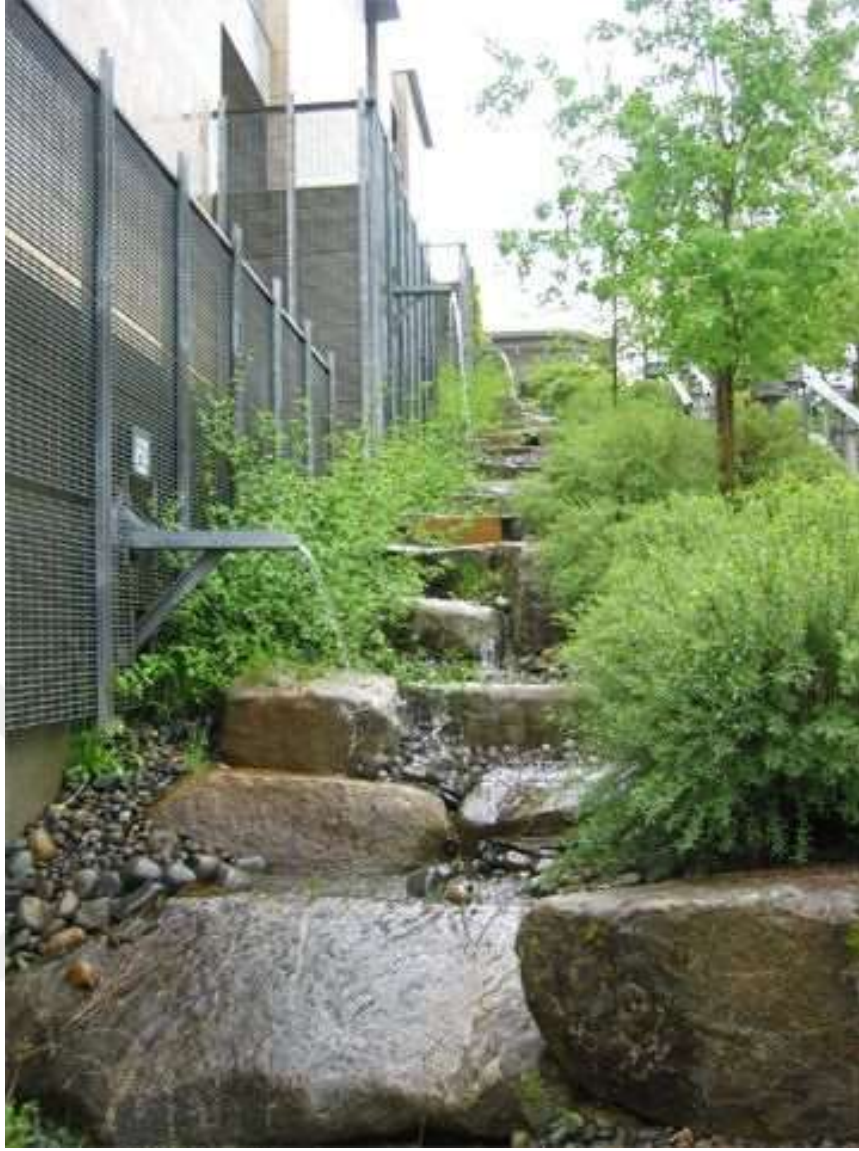
Şekil 2.24. Washington, ABD, çatılardan gelen akışı yöneten bir Doğal Drenaj Sistemi (URL-68)
