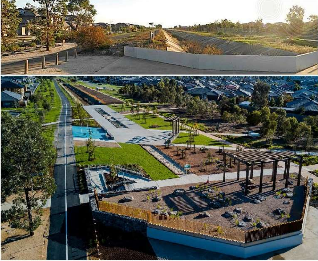
Şekil 2.19. Melbourne'un Ana Çıkış Kanalizasyonunun eski hali ve Suyu Duyarlı Kentsel Tasarım yaklaşımında dönüştürülmüş yeni hali (URL-66)
