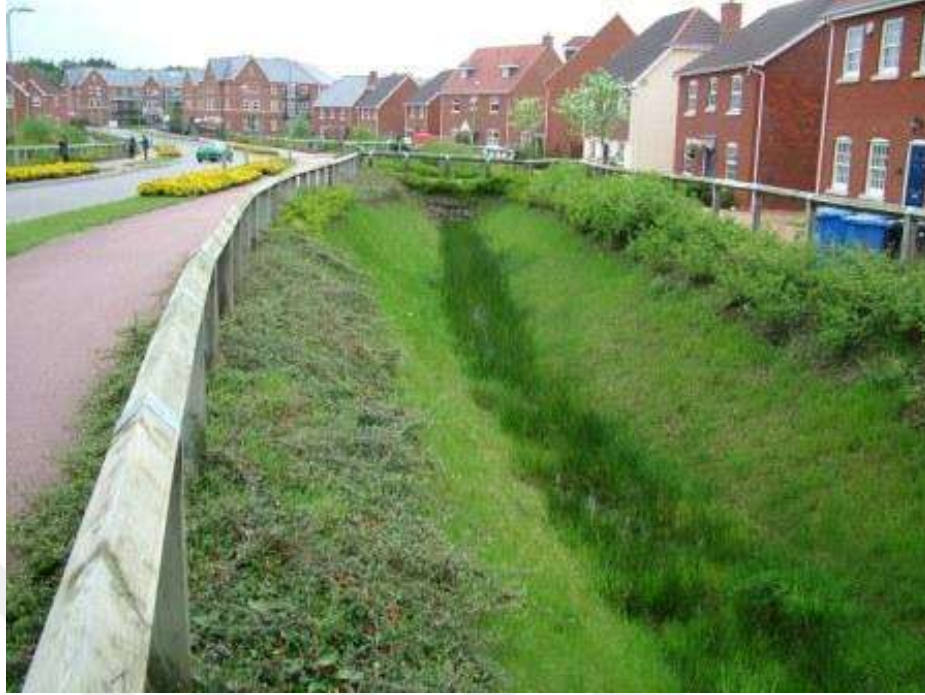
Şekil 2.21. İngiltere’den Sürdürülebilir Drenaj Sistemi olarak biyolojik hendek haline getirilmiş bir su kanalı örneği (URL-67)
