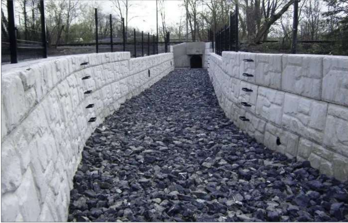
Şekil 1.41. Aşırı yağışlara dayanabilen yağış suyu kanalları (Url-27)
