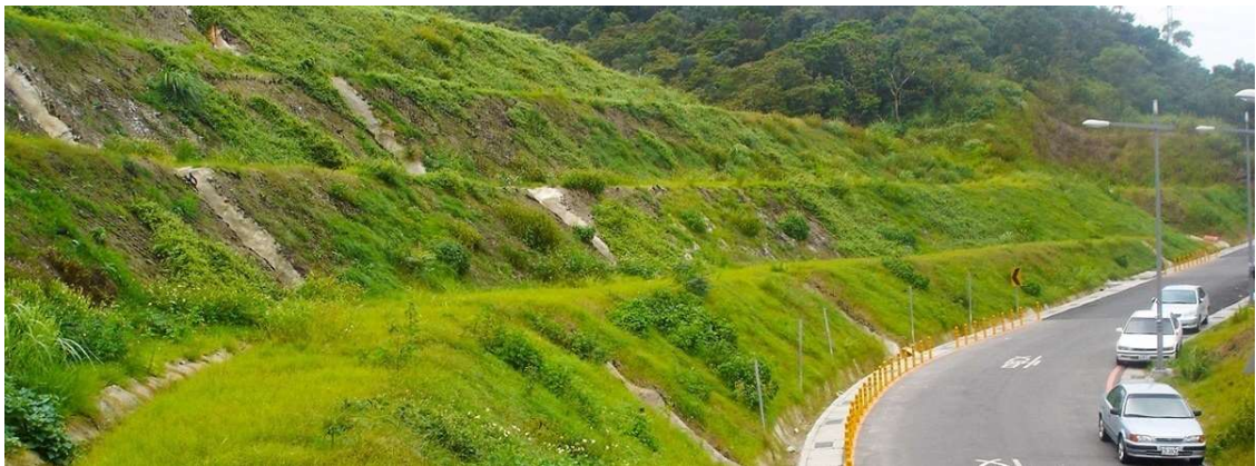
Şekil 2.16. Şev Yüzey Stabilizasyonu ve Koruması, Entegre Havza Yönetimin önemli bir parçasıdır, Keelung, Tayvan'dan bir uygulama (URL-64)
