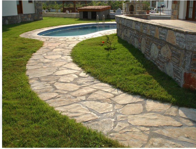
Şekil 2.39. Kayrak taşı döşeme.
