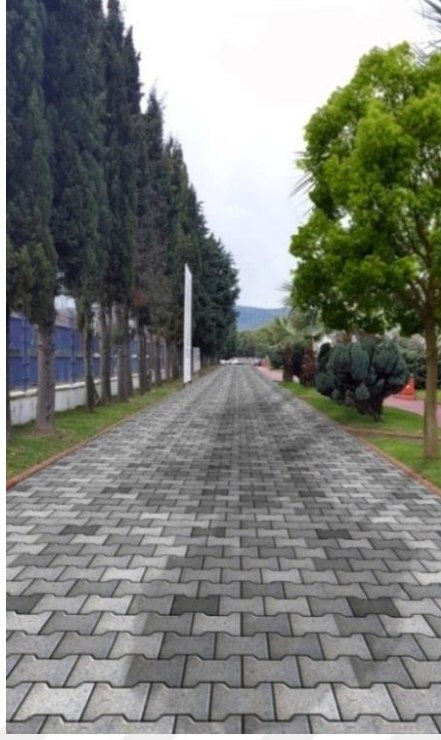
Şekil 3.12. Kilitli beton parke malzemesi kullanılan 9 No’lu kurgu tasar görüntüsü (Orijinal 2021).
