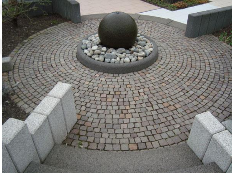
Şekil 2.17. Beton antik parke döşeme.
