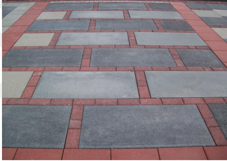
Şekil 2.15. Beton plak döşeme.
