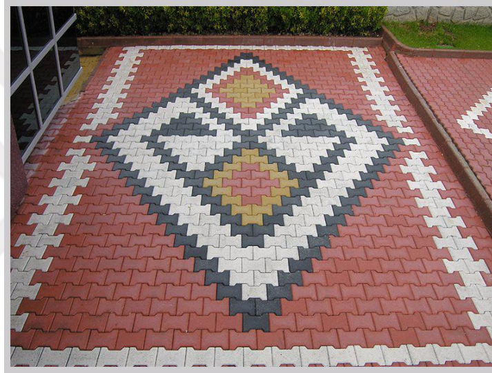
Şekil 2.13. Kilitli beton parke döşeme.
