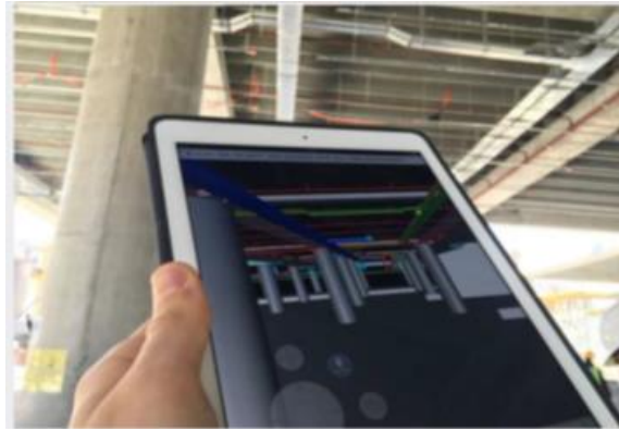
Şekil 3.11. Autodesk 360, tablet uygulamasıyla inşaat alanında projedeki ve yerindeki imalatların kontrolü.
