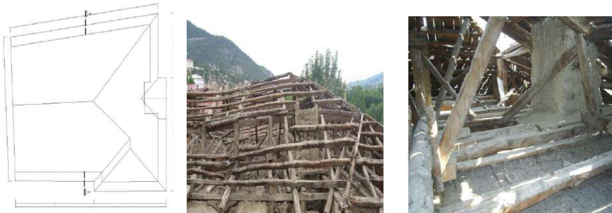
Şekil 25. Ali Pektaş Evi'ne ait rölöve çatı planı ve çatı görüntüleri
