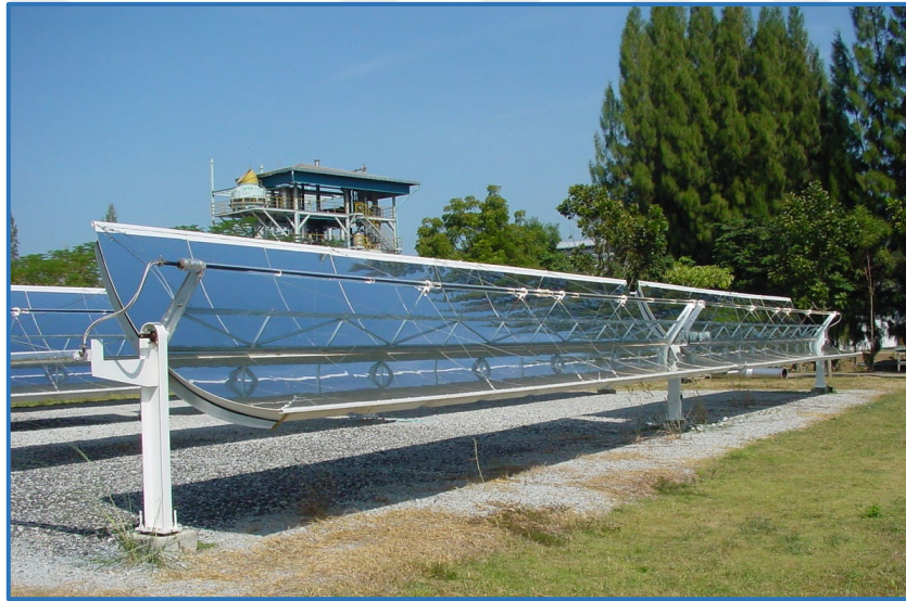
Şekil 4.16. Parabolik oluk kolektörler.
