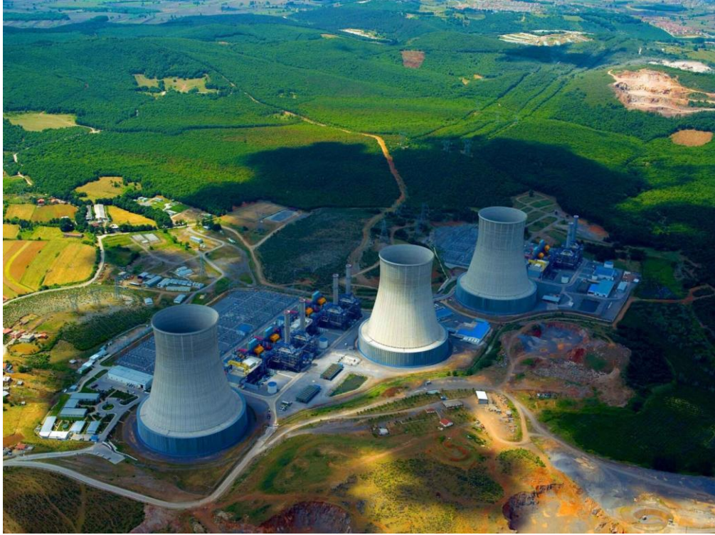
Şekil 2.4. Türkiye Gebze Doğalgaz Kombine Çevrim Santrali [87].
