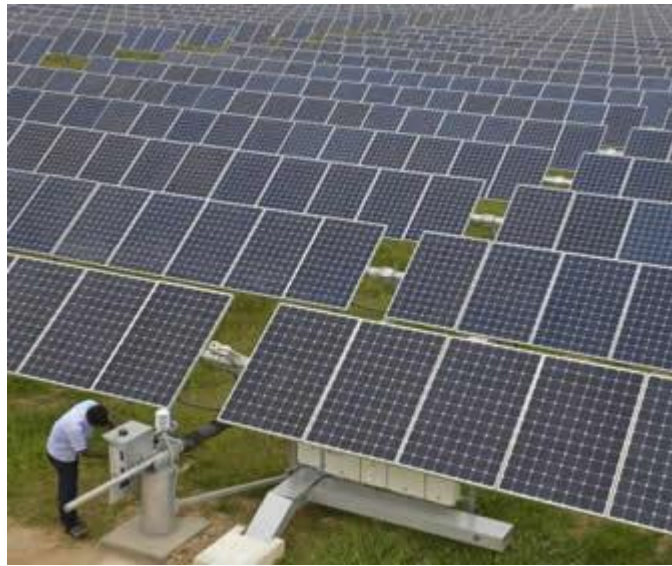
Şekil 2.7. Türkiye Karapınar YEKA-1 Güneş Enerji Santrali [96].
