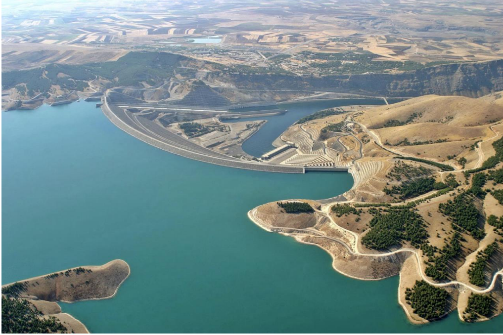
Şekil 2.5. Türkiye Atatürk barajı ve hidroelektrik santrali [92].
