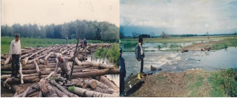
Şekil 6. Efteni sulak-alanı'nın yeniden kazanılması için 1992 yılında oluşturulmaya çalışılan sette inşaatı
