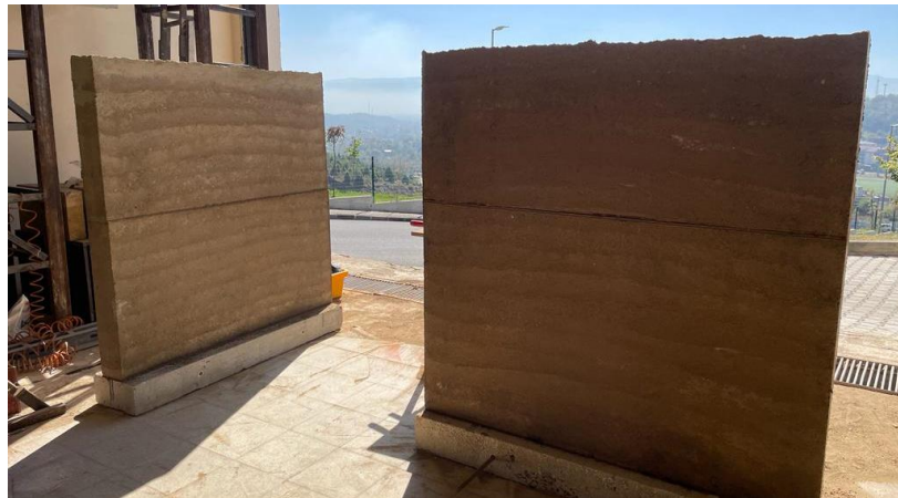
(d) Üretilen bazı duvarlar
