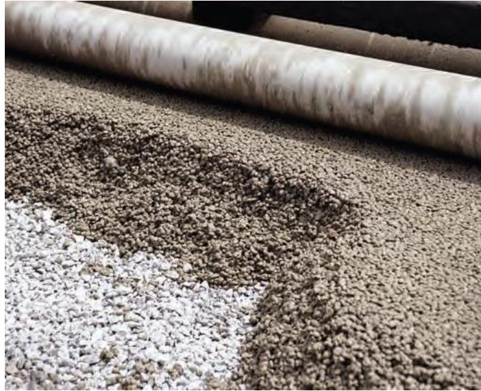
Şekil 2.13. Geçirimli betonunu silindir master ile sıkıştırılması [6].
