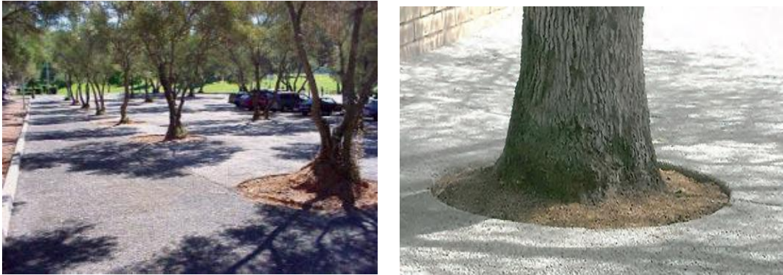
Şekil 2.4. Geçirimli betonun peyzaj alanlarında kullanımı (anonim).
