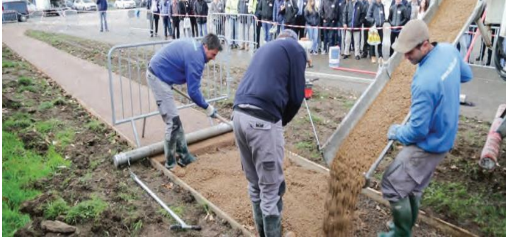
Şekil 2.12. Geçirimli beton döküm işlemi [6].
