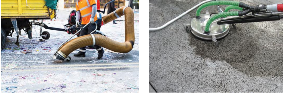
Şekil 2.14. Geçirimli beton bakım işlemleri [6].
