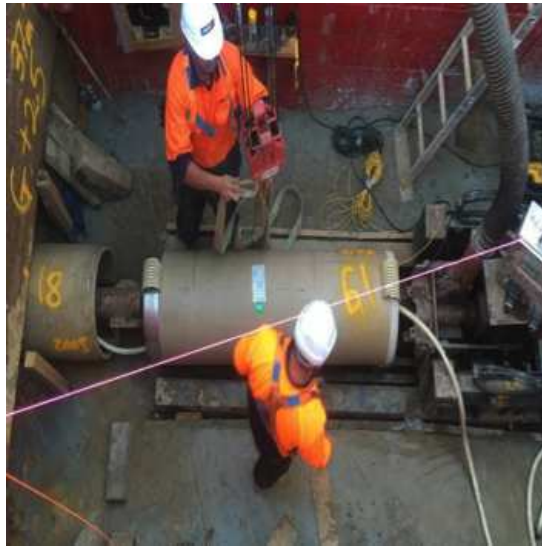
Şekil 2.4. İtme (jacking) CTP boru uygulaması.
