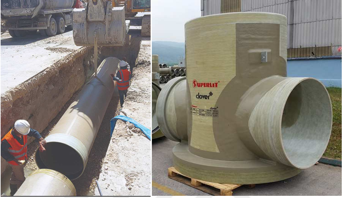
Şekil 2.3. Atık su kanalizasyon projesinde CTP boru a) Boru hattı b) Menhol.
