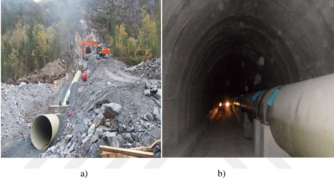
Şekil 2.5. CTP boruların cebri hatta ve iletim hattında uygulamaları a) Norveç b)Karaman – Balkusan hes.
