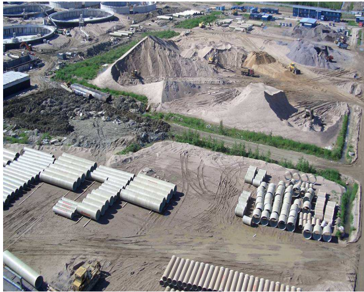
Şekil 2.2. Atık su arıtma tesisi projesinde CTP boru uygulaması.
