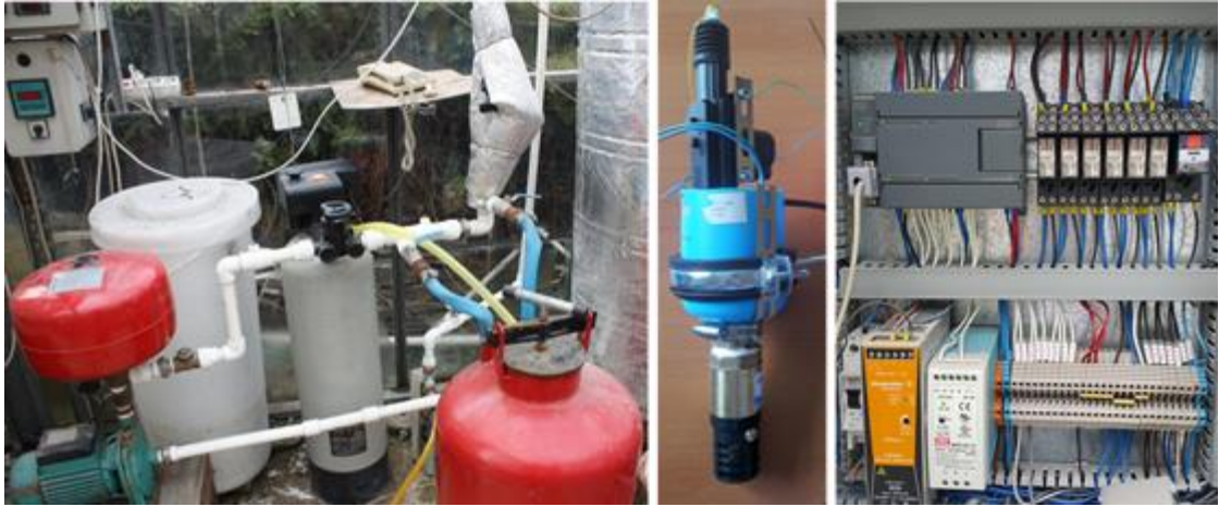
Şekil 2.6. Sulama sistemi cihazları, sulama miktarı ayarlama haznesi ve PLC.
