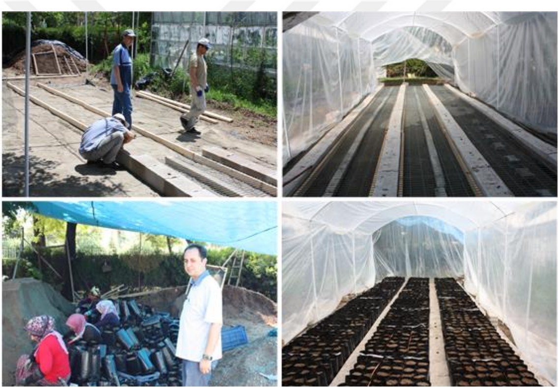
Şekil 2.3. Seranın inşası, fidan tüplerinin yerleştirilmesi.
