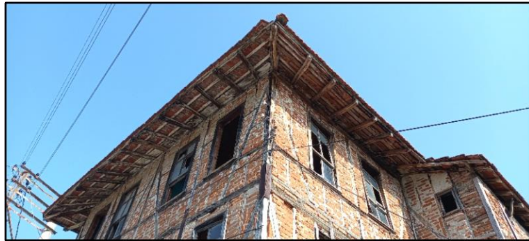
Şekil 2.20. 1799 parsel geniş çatı saçağı ve konstrüksiyonu.
