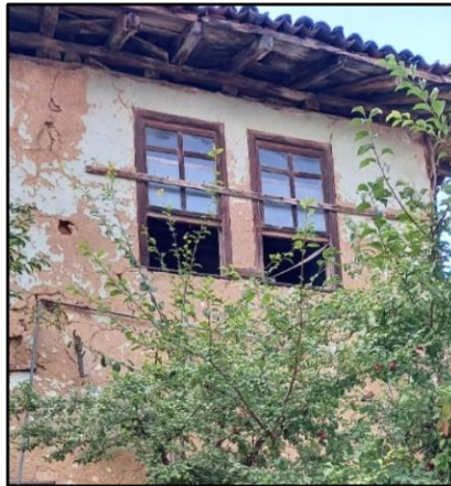
Şekil 2.25. 1766 parsel geniş çatı saçağı ve konstrüksiyonu.
