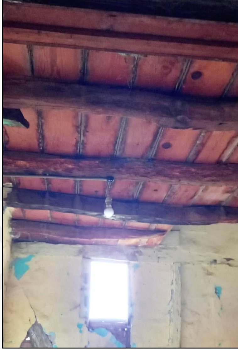
Şekil 2.15. Zemin kat tavan görünümü
