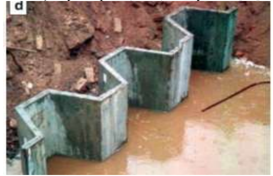
Prekast palplanj uygulaması [265]
