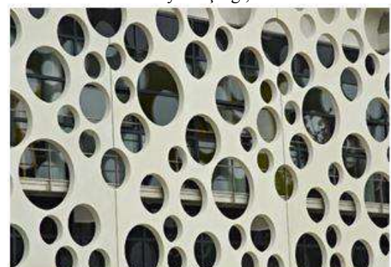
Plescop şehir holü cephesi için delikli cephe panelleri [266]
