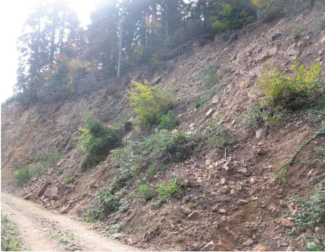
Şekil 1.4. Kazı şevinde kayma.
