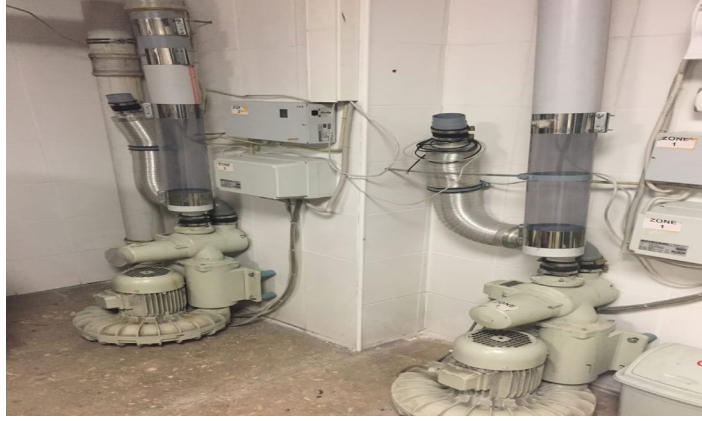
Şekil 4.13. Deneysel Çalışmaların Yapıldığı Kontrolü Sağlanan Blowera ait Görseller.
