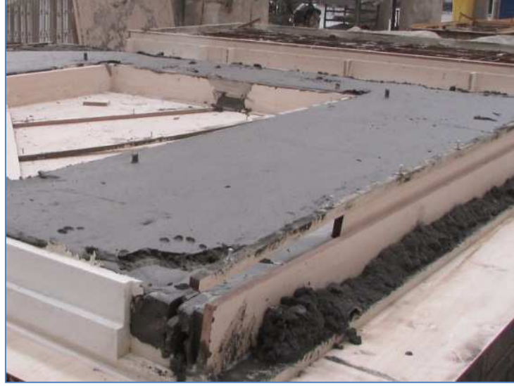
Şekil 4.13. Köpük betonun donatılı GFRC kabuk panele yerleştirilmesi.
