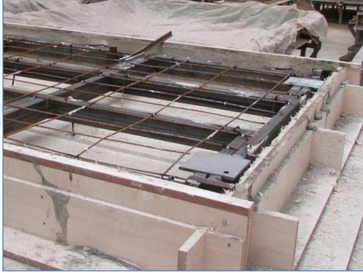
Şekil 4.12. Isı yalıtımlı panel GFRC kabuktan oluşturulmasından sonra içine çeliğin yerleştirilmesi.
