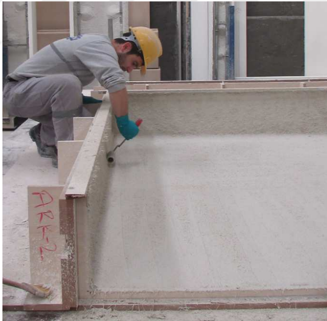
Şekil 4.3. Kalıba püskürtülen GFRC'nin rulolarla sıkıştırılması.
