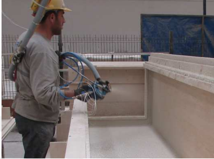
Şekil 4.2. El spreyi ile GFRC karışımın kalıba püskürtülmesi.
