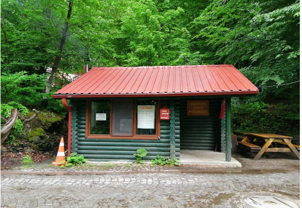
Görsel 3.15. Mengen giriş kontrol noktası.
