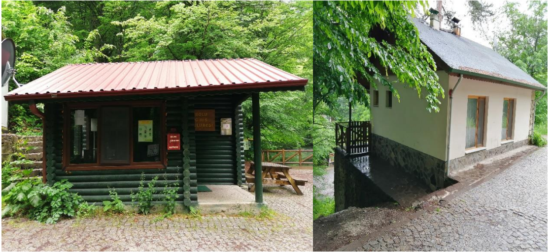
Görsel 3.4. Eski Bolu giriş kontrol noktası.
