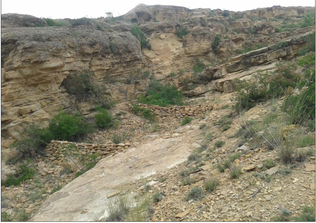
Şekil 3.1. Deliktaş köyünde yapılan kuru taş duvar eşiklerden görünüm.
