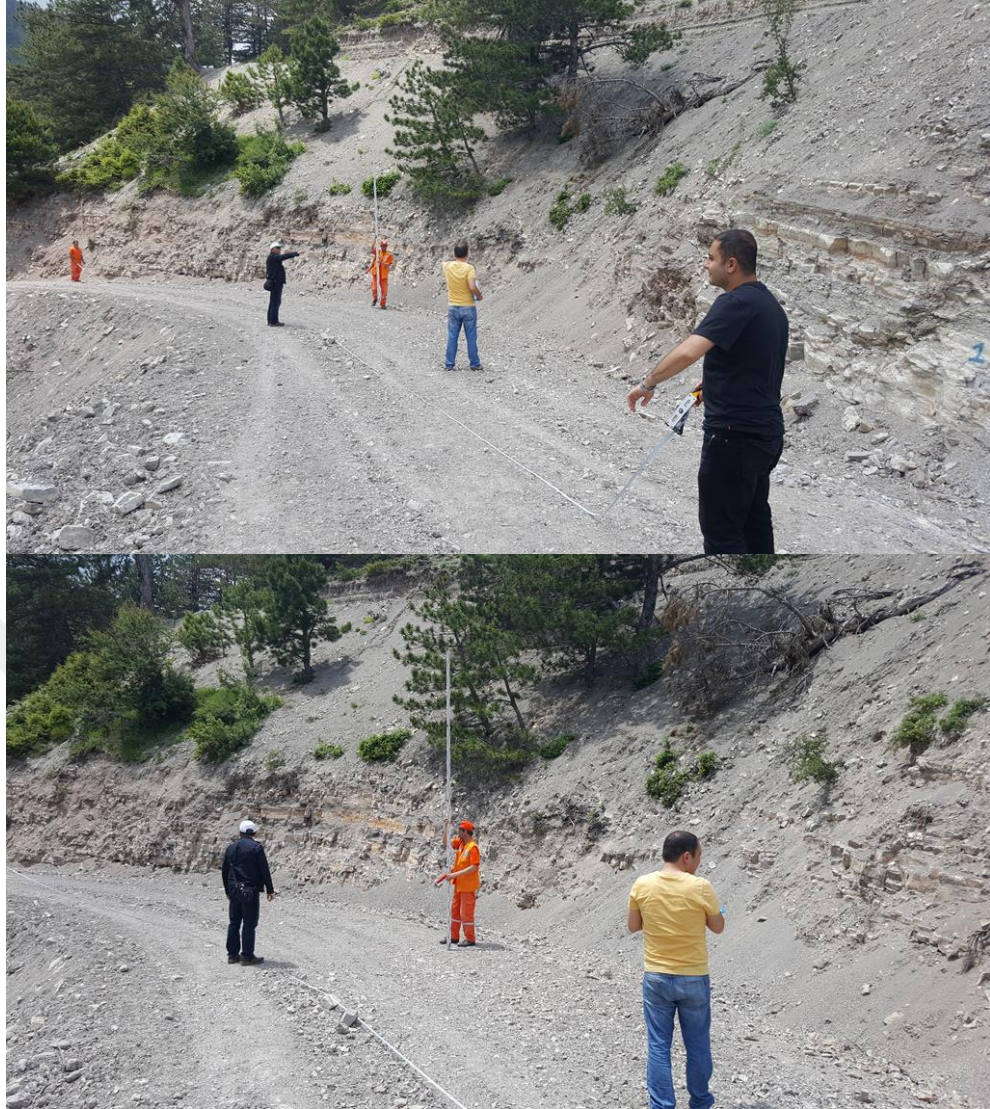
Şekil 1.4. Hakediş metraj cetvellerinin oluşturulması için yapılan arazi ölçümleri.
