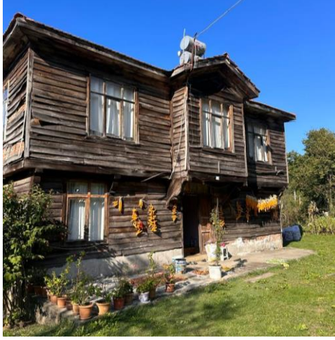
a) Güney cephesi
