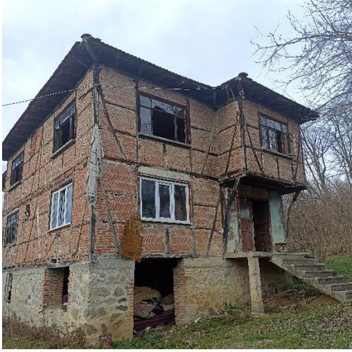
a) Güneydoğu cephesi
