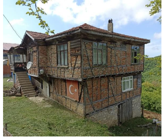
b) Güneydoğu cephesi
