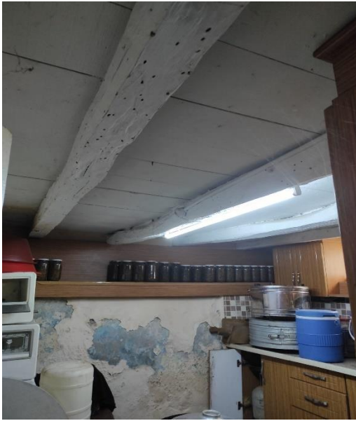
a) Ahşap tavan döşemesi
