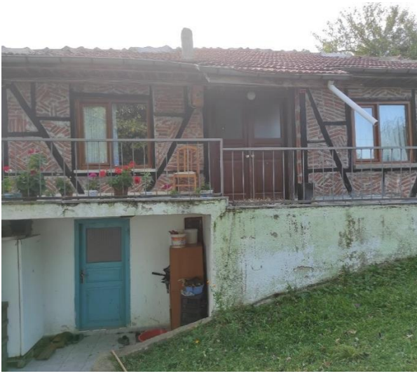
a) Kuzeybatı cephesi
