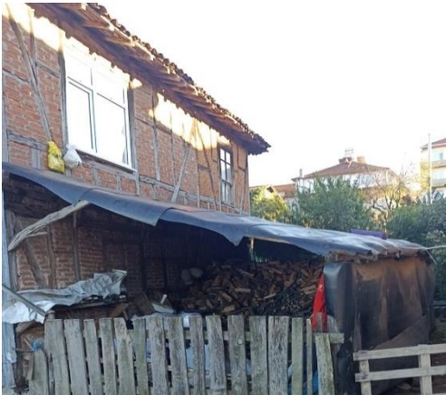
a) Kuzey cephesi
