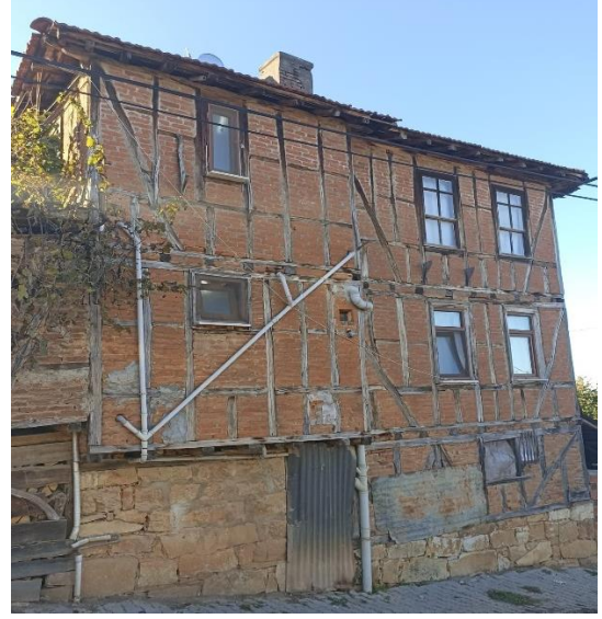
b) Doğu cephesi
