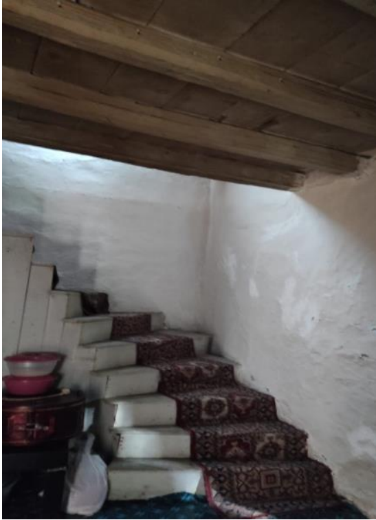
a) Ahşap merdiven ve tavan
