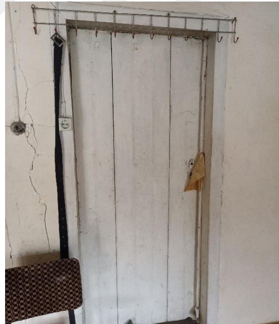
b) H2 evi ahşap iç kapı
