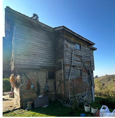
b) Doğu cephesi
