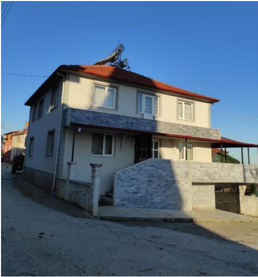
a) Yeni yapı
