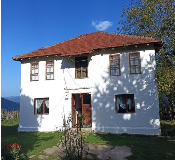
a) Batı cephesi
