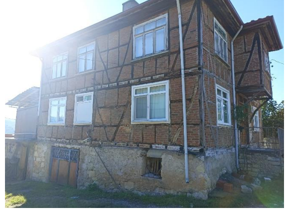
b) Güneydoğu cephesi
