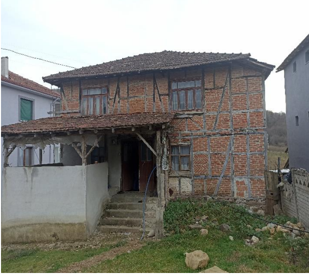
a) Kuzey cephesi
