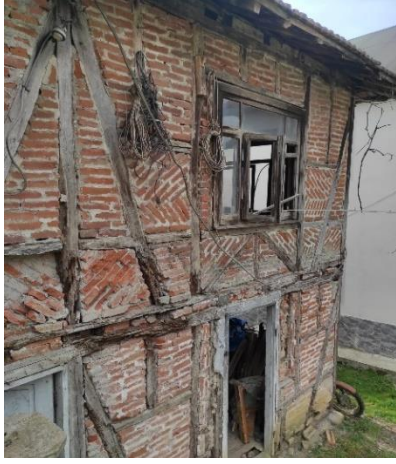
a) Özgün yapı
