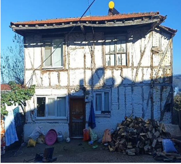
a) Batı cephesi
