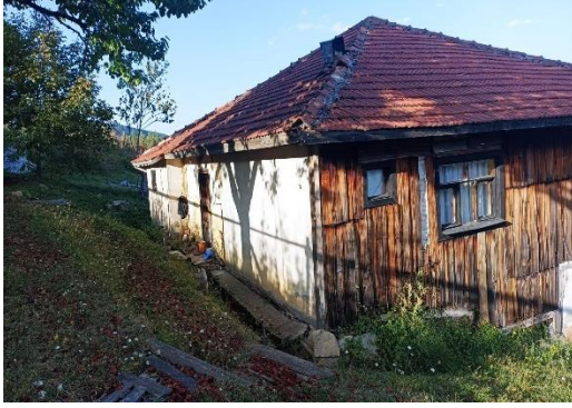
a) Kırma çatı
