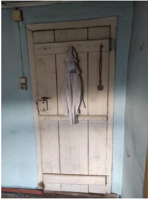
a) Ahşap iç kapı
