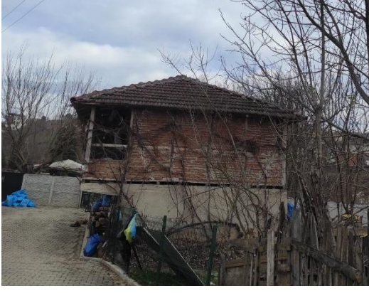
a) Kırma çatı
