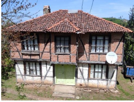
a) Güney cephesi
