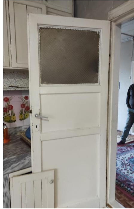
b) H1 evi ahşap iç kapı
