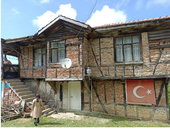
a) Güney cephesi
