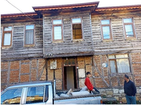
a) Kuzey cephesi
