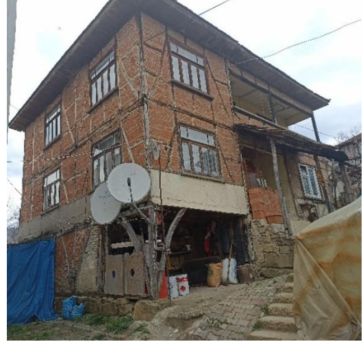
b) Güneydoğu cephesi
