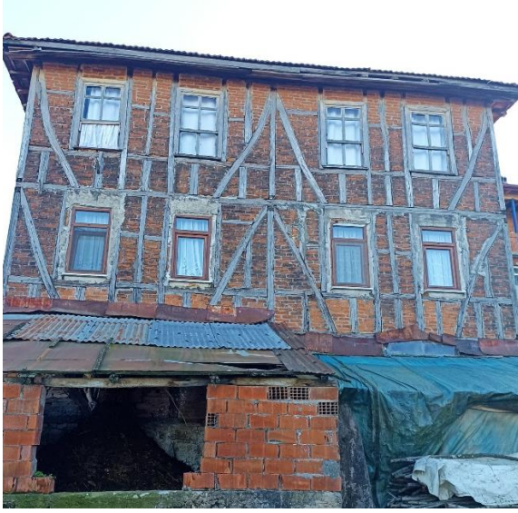
a) Kuzey cephesi
