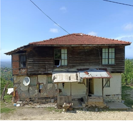
a) Güney cephesi
