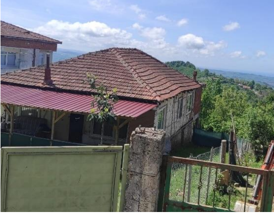
a) Kırma çatı
