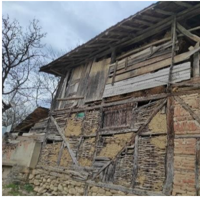
a) Ahşap karkas yapım tekniği
