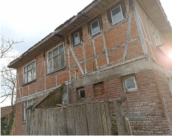
a) Kuzey cephesi
