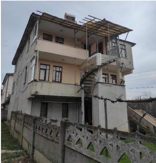
a) Üç katlı yapı
