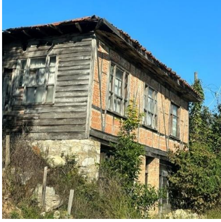
a) Özgün yapı
