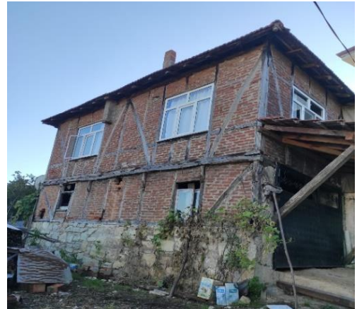
b) Ahşap karkas yapım tekniği
