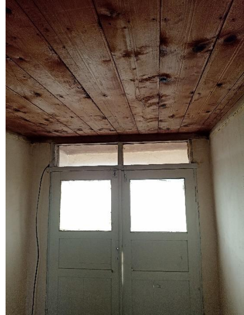
b) Ahşap tavan döşemesi
