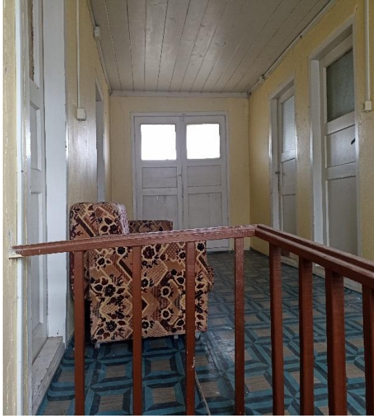
a) Ahşap iç kapı, korkuluk ve döşeme
