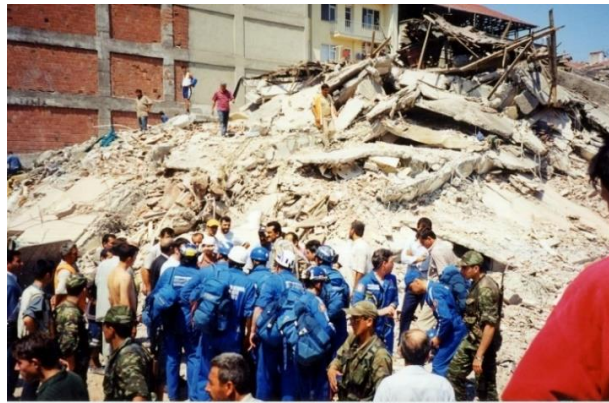
Şekil 5.6. İmar affından faydalanan Ersoy apartmanı.
