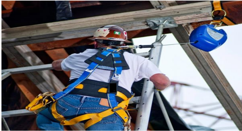
Şekil 3.8. Kişisel düşmeyi durdurma sisteminin doğru kullanımı.
