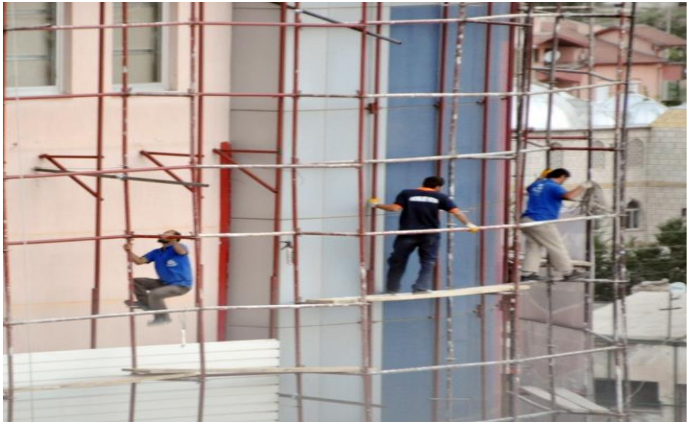
Şekil 3.4. İskelede güvenlik önlemi alınmadan yapılan çalışma.
