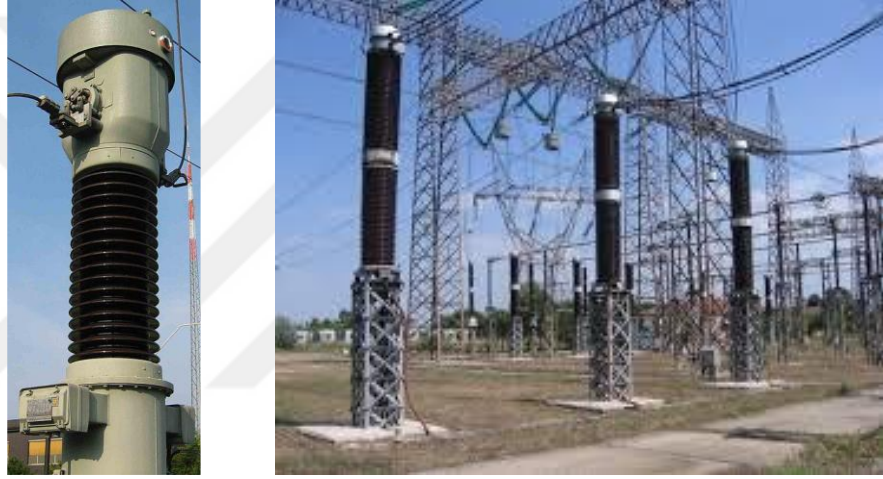
Şekil 2.18. Ölçü Transformatörleri (Akım ve Gerilim Transformatörleri)
