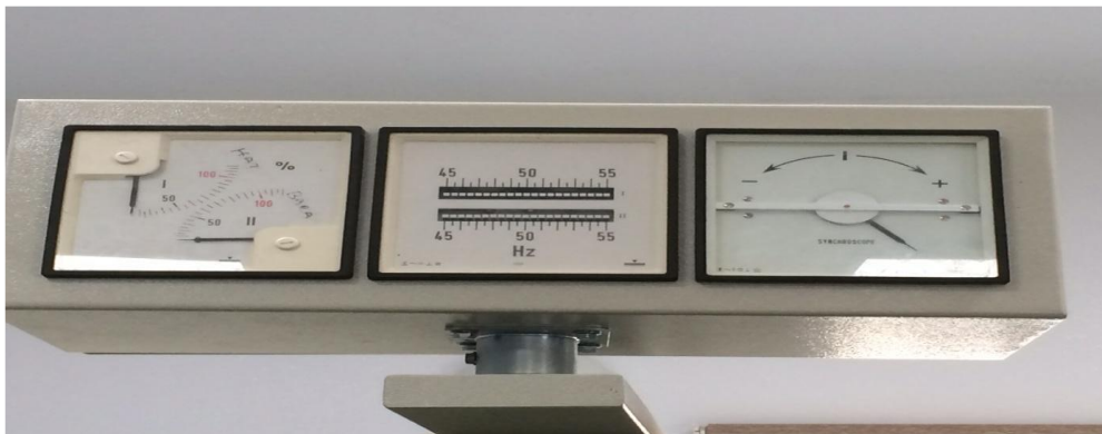
Şekil 2.14. Senkronoskop Panosu
