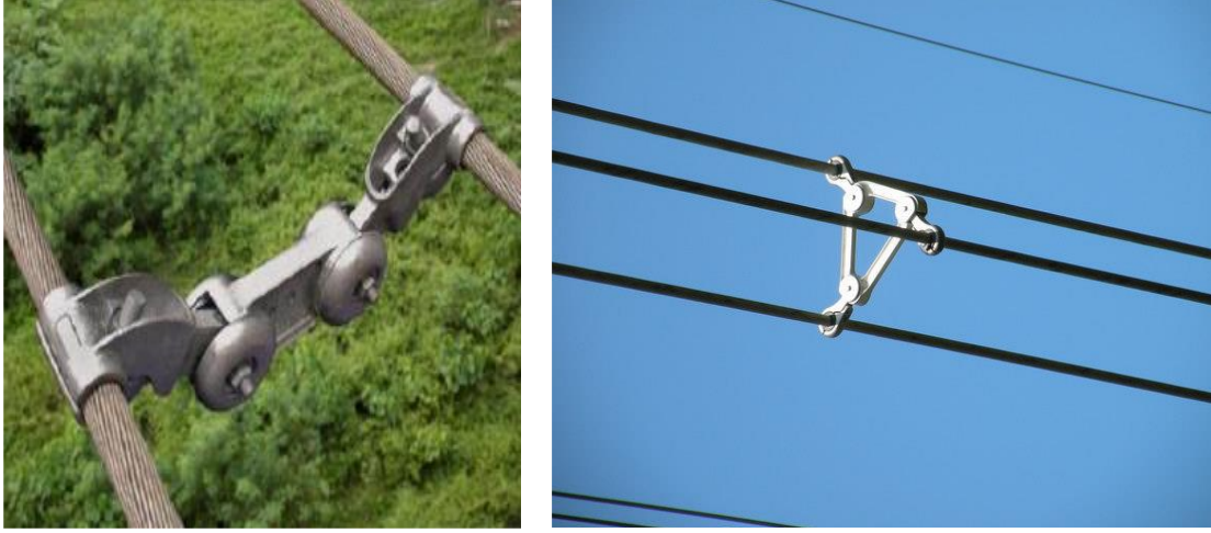
Şekil 2.27. Çeşitli Ara Tutucular (Spacer)
