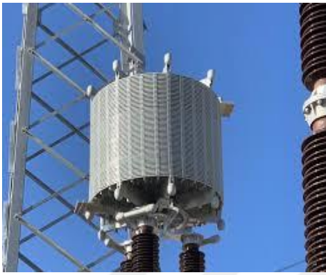
Şekil 2.26. Hat Tıkacı(Line Trap) ve Bağlantı Şeması
