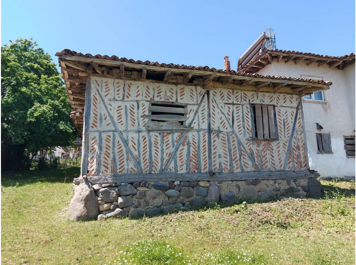
Şekil 3.62. Ergül evi sağ yan cephe fotoğrafı
