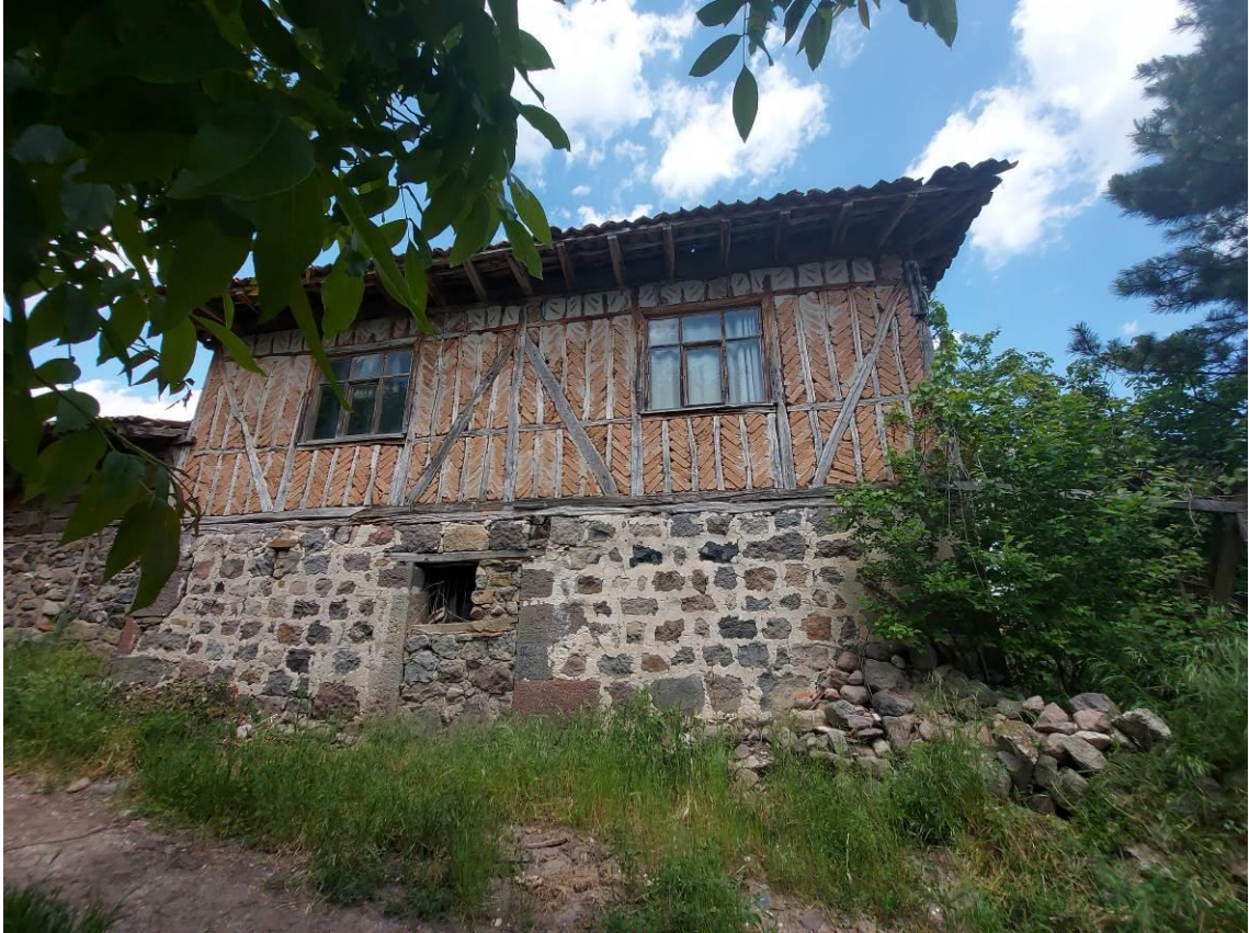
Şekil 3.51. Temiz evi sol yan cephe fotoğrafı
