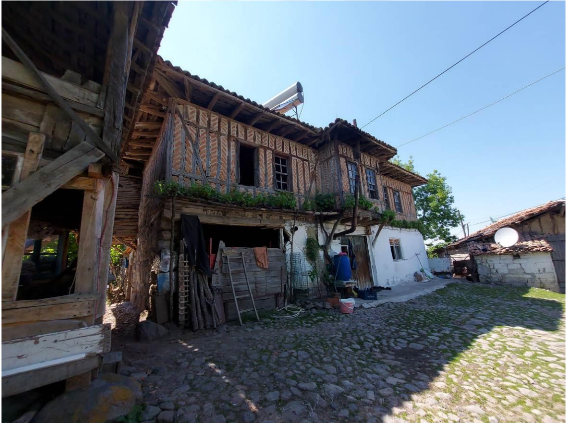
Şekil 3.96. Yazar evi ön cephe fotoğrafı
