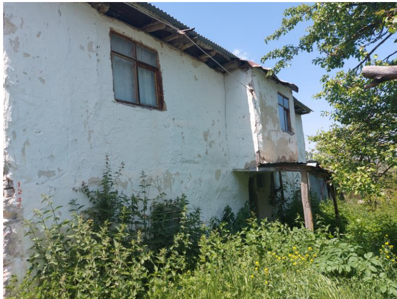
Şekil 3.83. Şahin 2 evi ön cephe fotoğrafı
