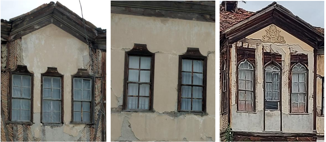
a) Arka cephe pencere örneği b) Giyotin pencere örneği c) Pencere üstü süsü örneği
