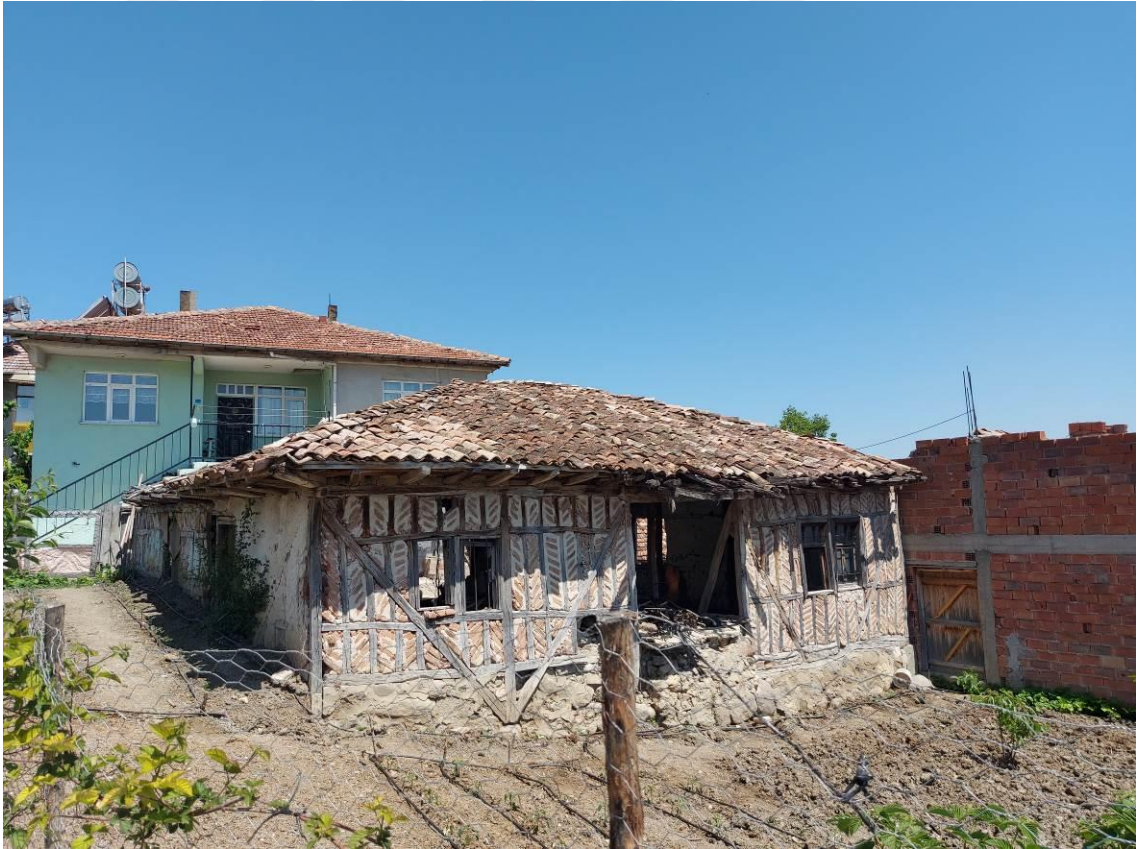
Şekil 3.66. Gündüz evi ön cephe fotoğrafı
