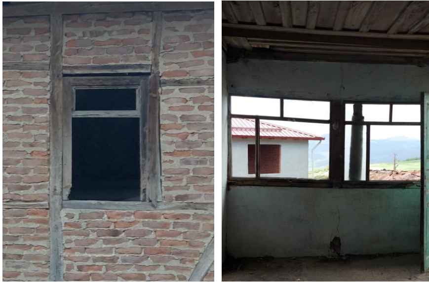
a) Giyotin pencere örneği b) Düz pencere örneği
