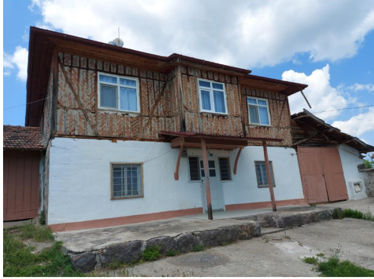
Şekil 3.116. İyi durumdaki konut örneği
