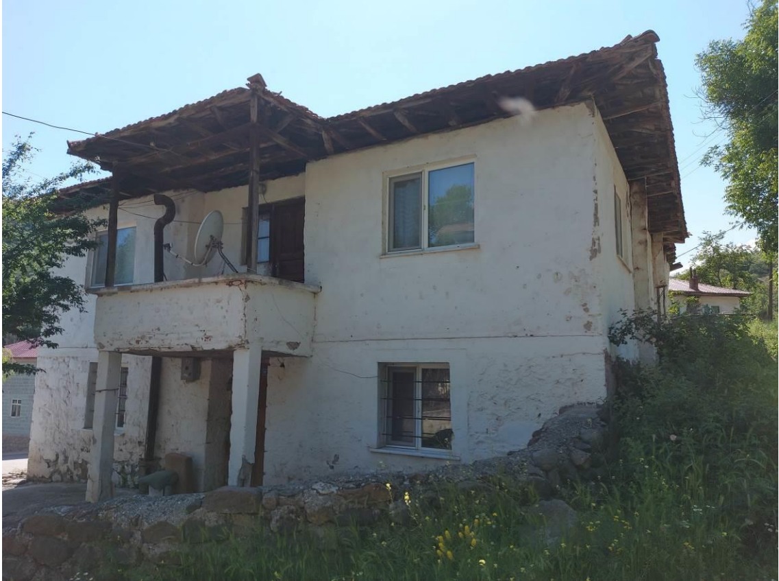
Şekil 3.106. Ayhan evi ön cephe fotoğrafı
