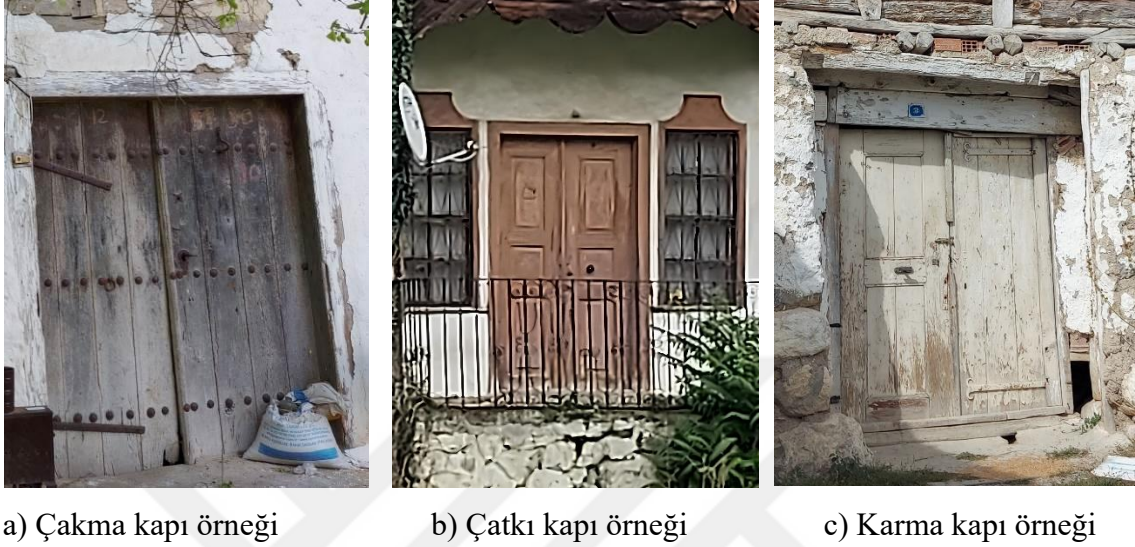
Şekil 3.120. Ahşap kapı yapım tekniği örnekleri
