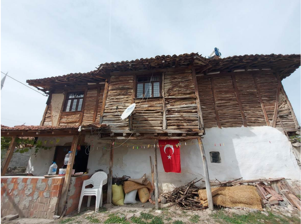
Şekil 3.29. Karaođlan 2 evi ön cephe fotoğrafı
