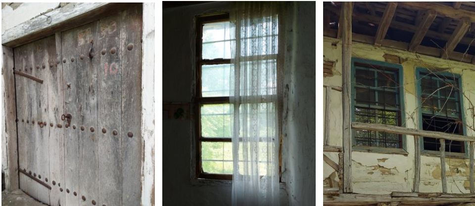
a) Giriş kapısı örneği b) Giyotin pencere örneği c) Giyotin pencere örneği
