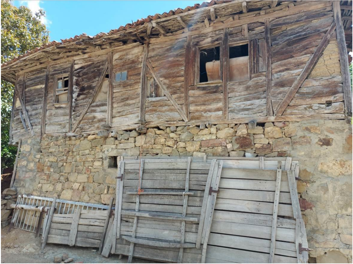
Şekil 3.43. Çavdarlar evi arka cephe fotoğrafı
