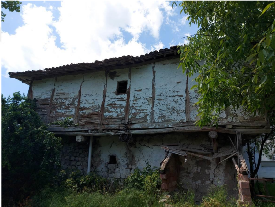
Şekil 3.53. Koçoğlu evi sol yan cephe fotoğrafı
