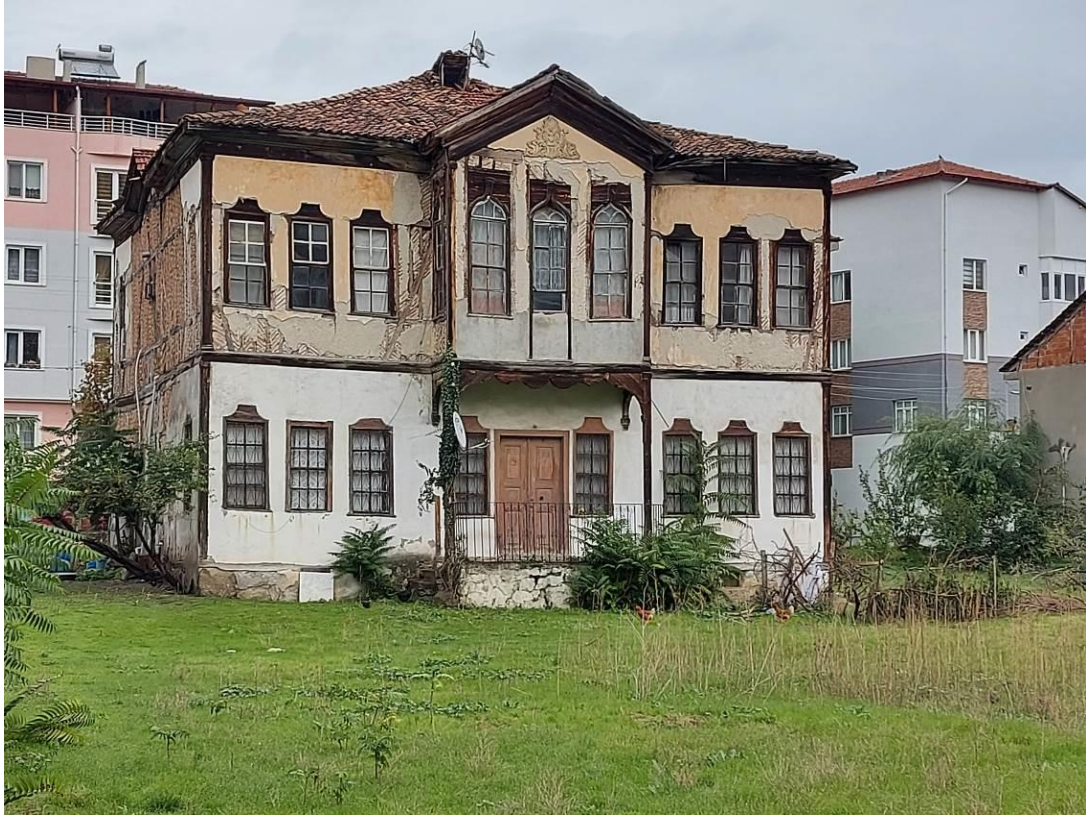
Şekil 3.2. Ali Osman Ağa Konağı ön cephe fotoğrafı
