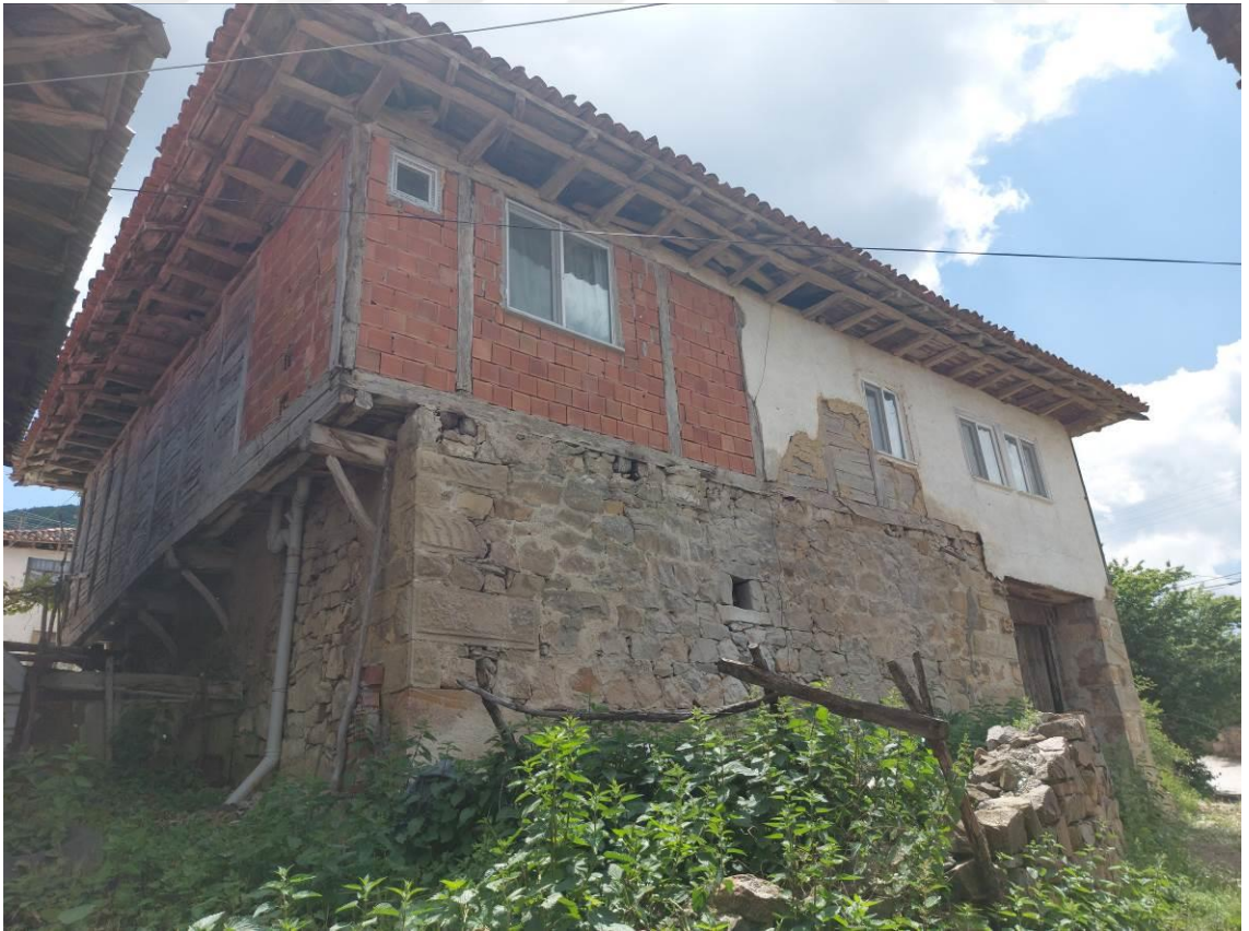
Şekil 3.39. Çavdarlar evi arka cephe fotoğrafı
