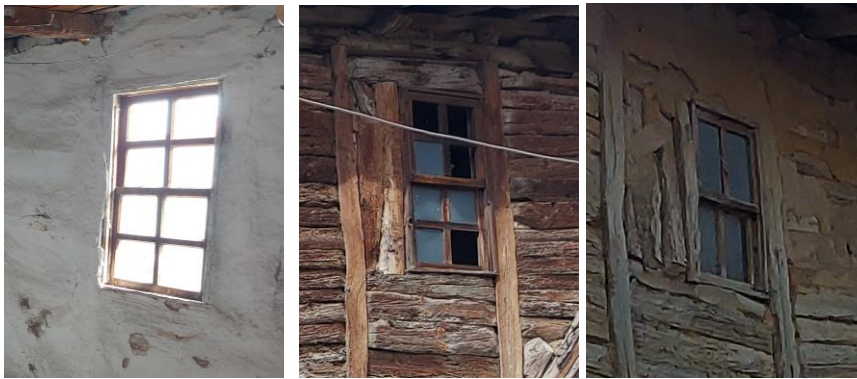
a) Giyotin pencere örneği b) Giyotin pencere örneği c) Giyotin pencere örneği
