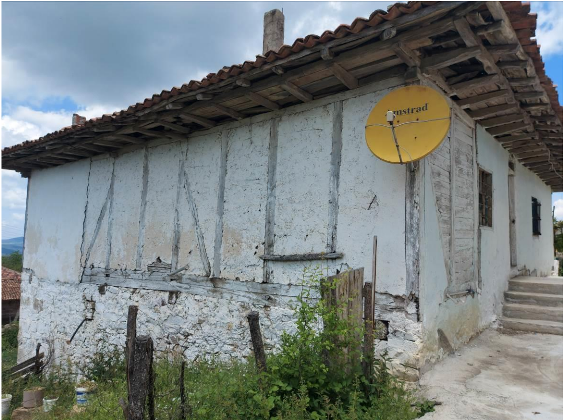
Şekil 3.37. Çavdarlar evi fotoğrafı
