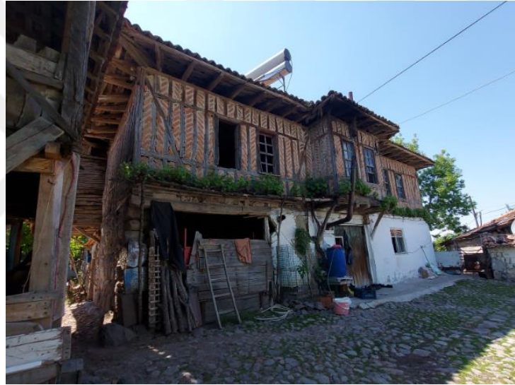
Şekil 3.117. Orta durumdaki konut örneği
