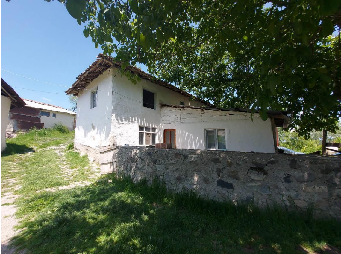
Şekil 3.77. Turhan evi sol yan cephe fotoğrafı
