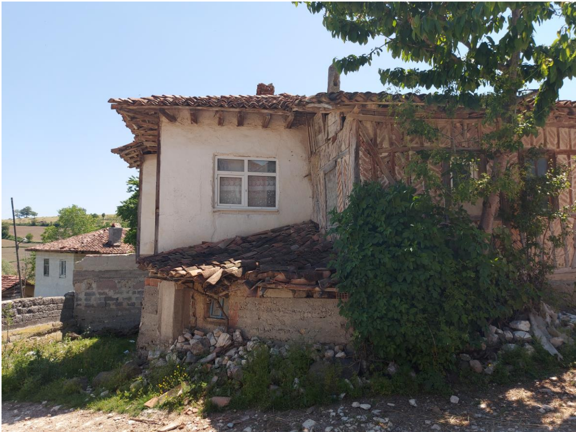
Şekil 3.68. Karakütük evi ön cephe fotoğrafı
