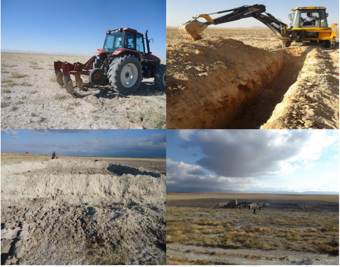
Şekil 2.10. Etrafında drenaj hendekleri açılarak oluşturulan deneme üniteleri.
