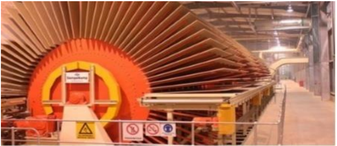
Şekil 1.12. Yıldız soğutma ünitesi.
