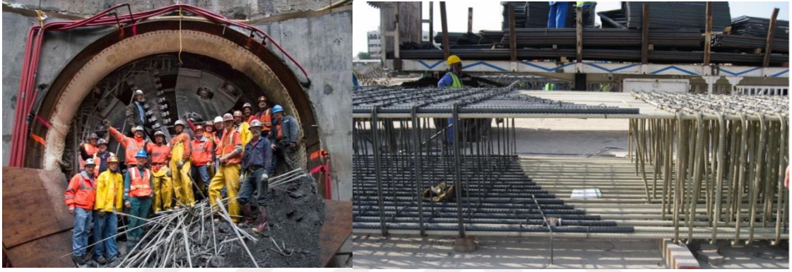
Şekil 2.5. Lif takviyeli kompozit donatıların TBM ile tünel açma çalışmalarındaki soft-eye çıkışları olan soft-eye uygulaması [21].
