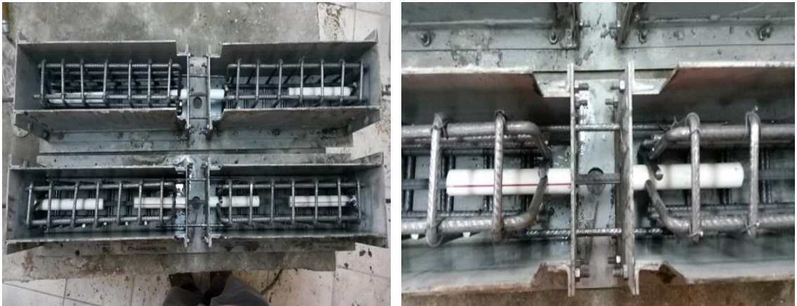
Şekil 5.13. Beton dökümüne hazır hale getirilmiş kalıp örneği.
