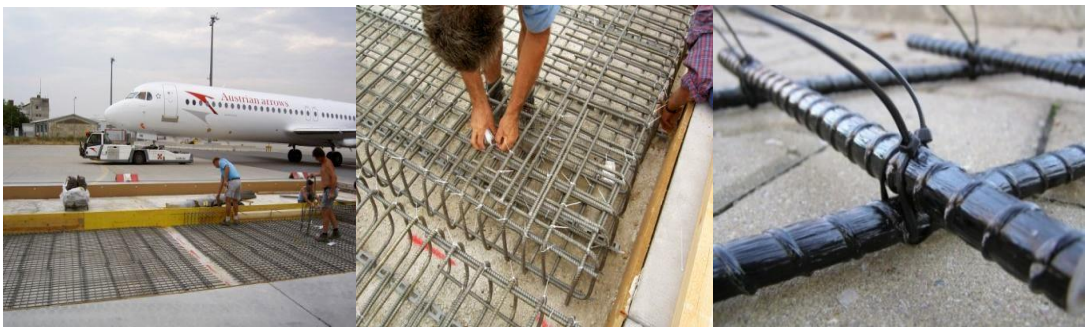
Şekil 2.6. Lif takviyeli kompozit donatıların havalimanında kullanımına örnek [22].
