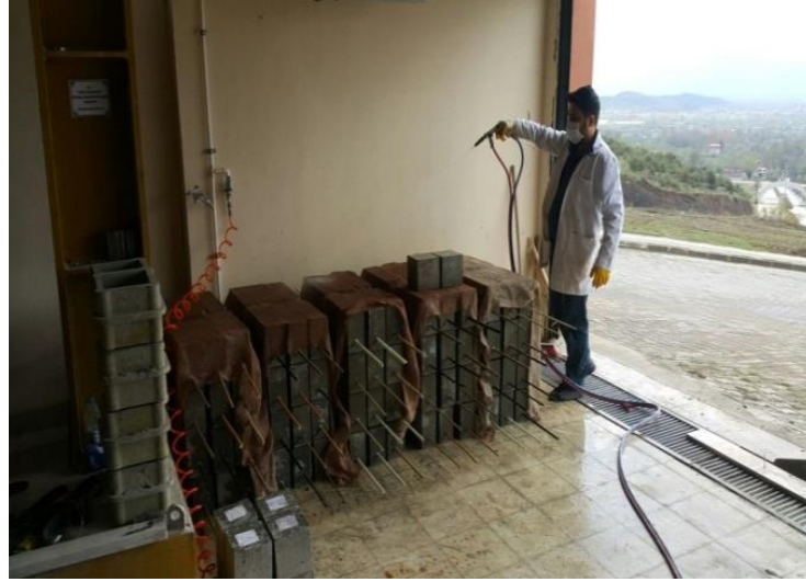
Şekil 5.17. Üretilen mafsallı kirişlere ıslak çuvallarla kür uygulanması.
