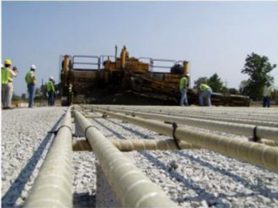
Şekil 2.8. Amerika'nın West Virginia eyaletinde yol yapımına ait görüntü.
