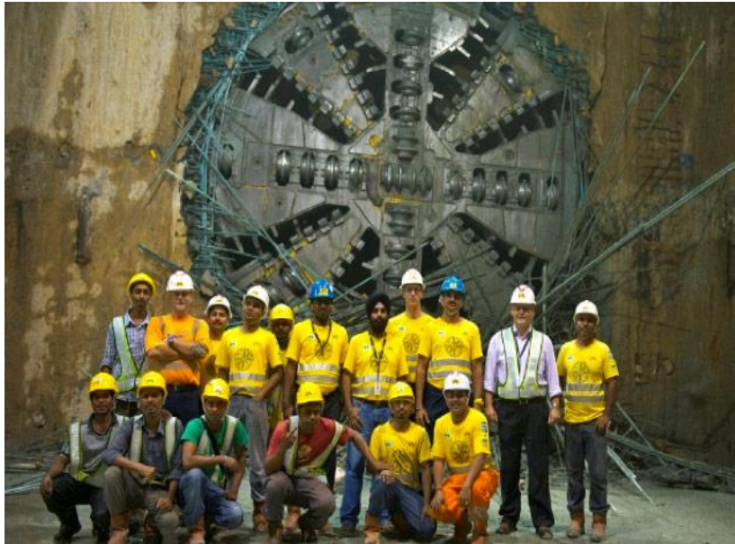
Şekil 2.16. Singapur'da King Albert Park İstasyonundaki TBM şaft çıkışı soft-eye uygulaması
