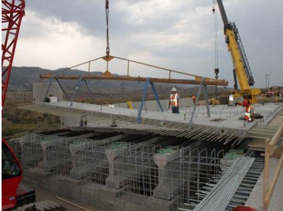
Şekil 2.10. Amerika’nın UTAH eyaletinde inşa edilen Emma Park köprüsü tabliyeleri.
