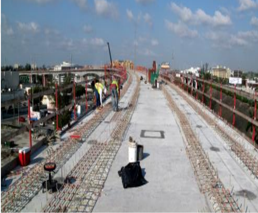
Şekil 2.12. Amerika'nın Florida eyaletinin Miami şehrinde metro inşaatındaki yol yapımı.
