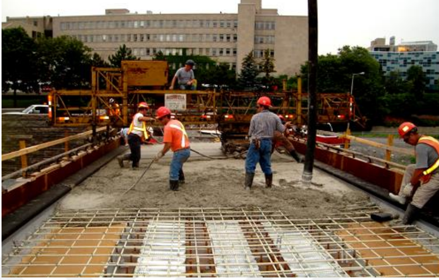
Şekil 2.13. Kanada'nın başkenti olan Ottawa'da yer alan Pedestrian Köprüsü tabliyesi.
