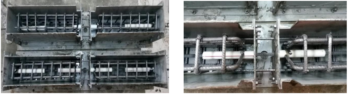
Şekil 4.9. Donatıların kalıba yerleştirilmesi.
