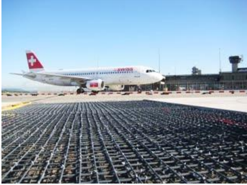
řekil 2.20. İsvire'nin Zrich-Flughafen'de bulunan Zrich Havalimanında Lif takviyeli kompozit donatılı dşeme uygulaması.
