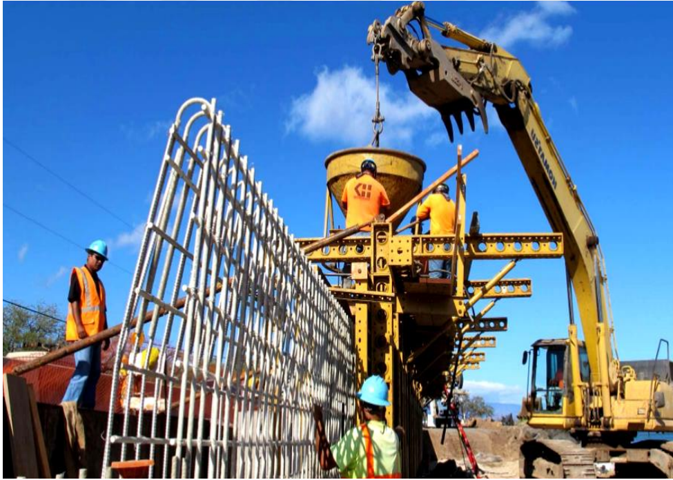
Şekil 2.6. Hawaii Maui adası Honoapiilani karayolu lif takviyeli kompozit donatılar ile yapılan bir istinat duvarı.
