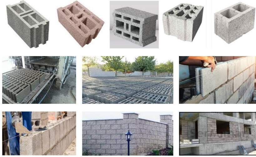
Şekil 5.4. Bims-briket malzemesi ve bims&briket betonun uygulanması.
