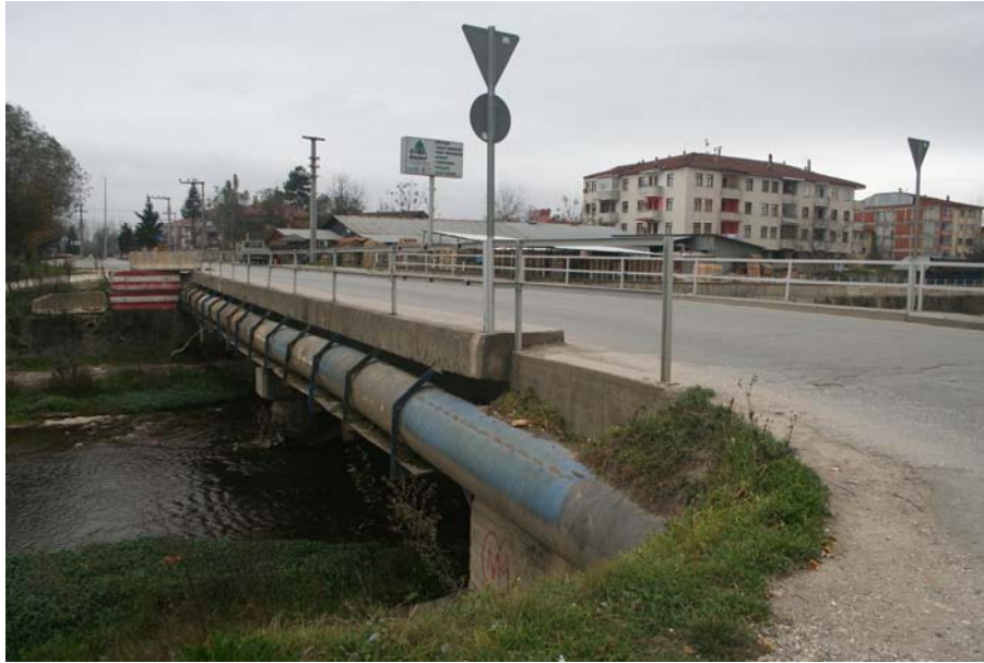
Şekil 4.17. Cedidiye Mahallesindeki Köprü (Özdede, 2010)
