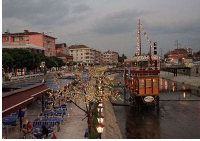
Şekil 4.14. 2009 Yılındaki Islah Sonrası Asarsuyu Deresi İçerisine Yerleştirilen Gemi Formlu Kafeterya (Anon 2010, e)
