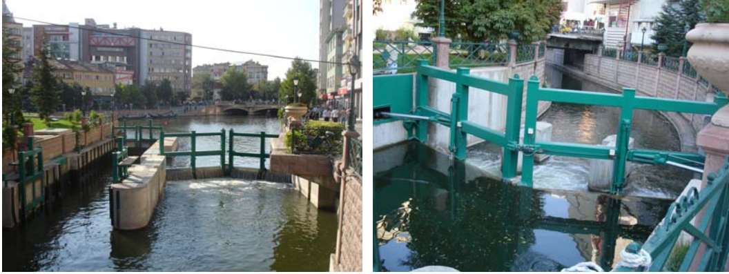
Şekil 5.1a,b. Eskişehir Su Seviye Kontrol Yapıları (Özdede, 2010)
