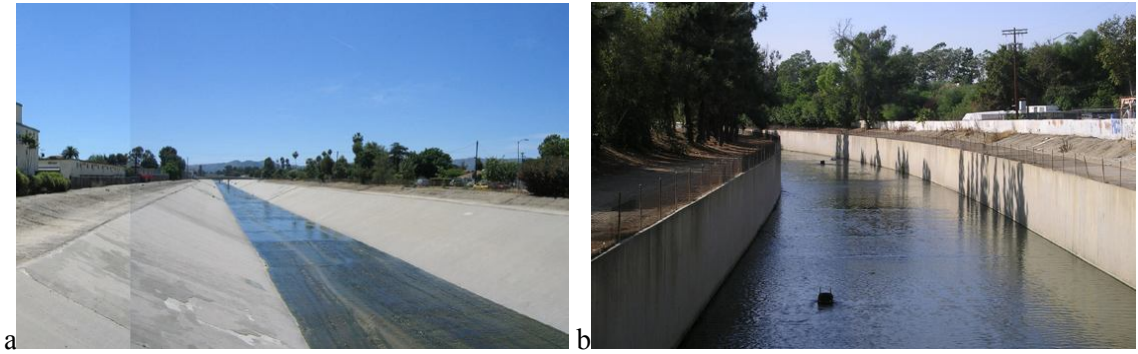
Şekil 2.35a,b. Canoga Park'taki Tipik İkizkenar Yamuk Şeklindeki ve Tipik Diktörtgen Şeklindeki Kanal Örneği (Los Angeles Master Plan,2007)
