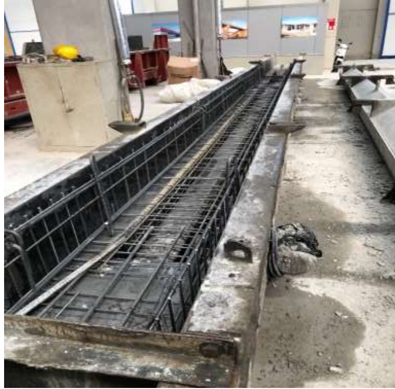
Şekil 3.2. Örnek prefabrike kolon imalatı.
