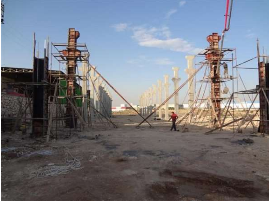
Şekil 3.1. Örnek yerinde döküm betonarme sistem kolon imalatı [36].
