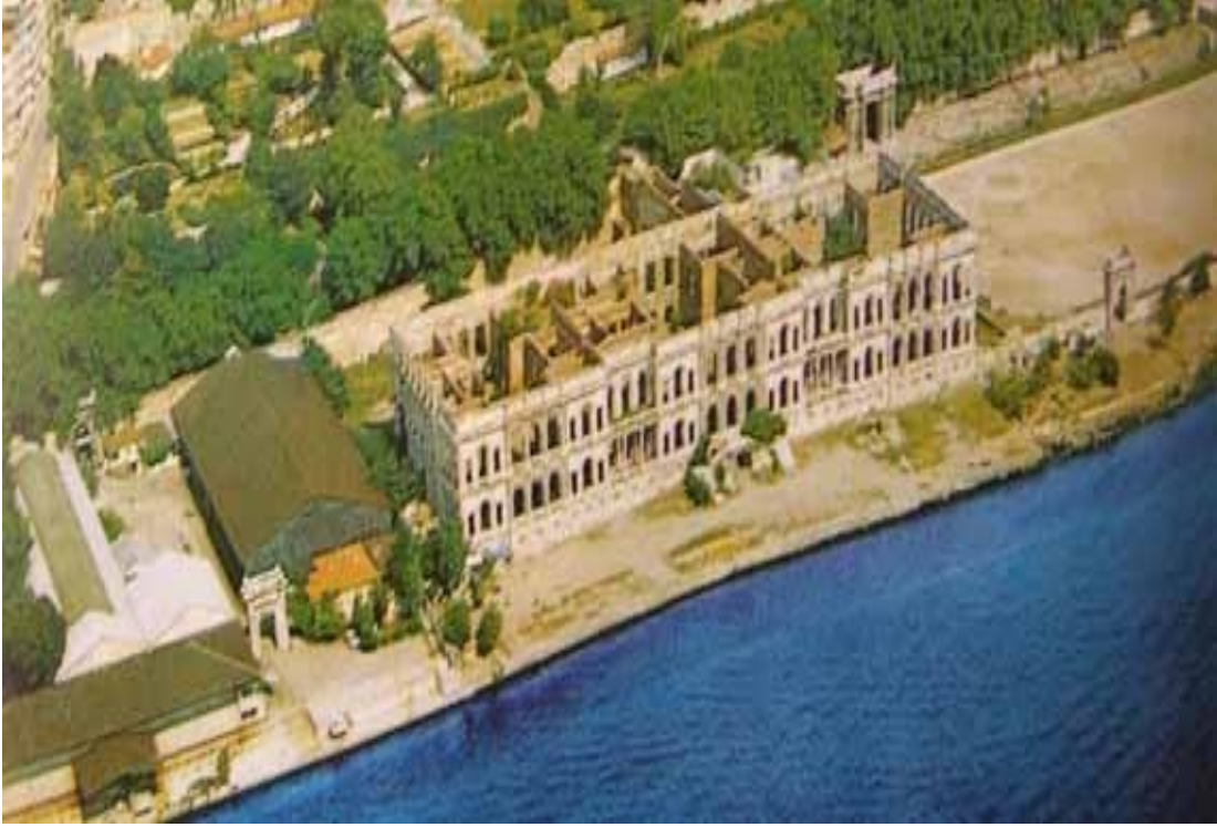
Şekil 1.10. Çırağan Sarayı: 1910 yangını sonrası dört duvarı kalan sarayın 1980'li yıllardaki görünüşü.
