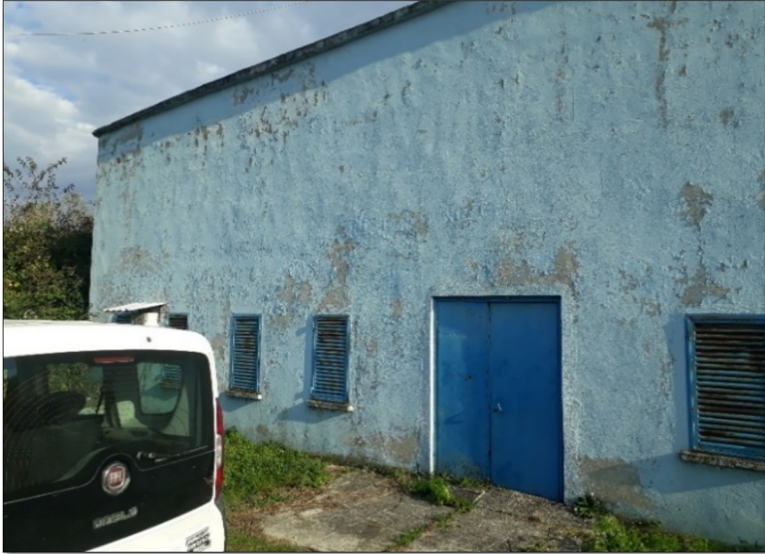
Şekil 2.17. Arıtma tesisi su depoları.
