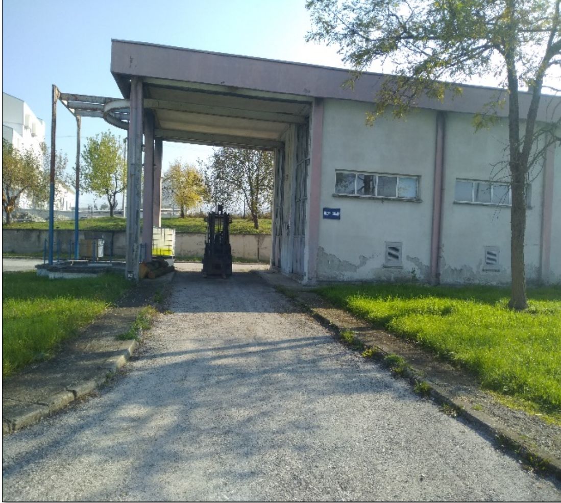
Şekil 2.15. Arıtma tesisi kimyasal depolar bölümü.
