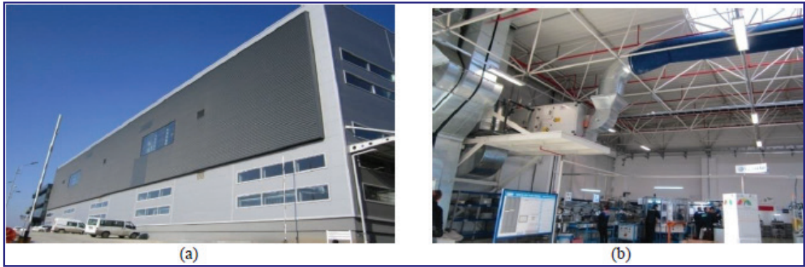
Şekil 8. Otomotiv üretim tesisi (a) Güneş duvarı (b) Güneş duvarı hava kontrol ünitesi [12]
