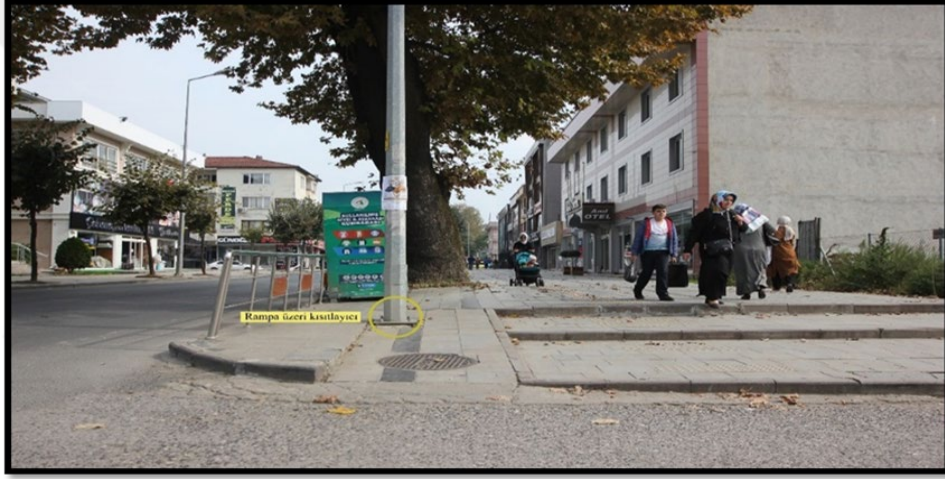
Şekil 3.10. Rampa üzerinde elektrik direkleri (Orijinal, 2019).
