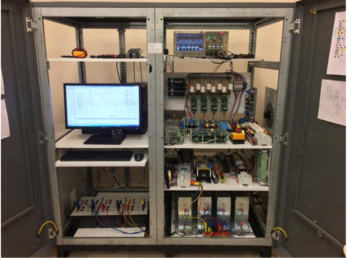
Şekil 3.2. 3-fazlı 4-kollu 3-seviyeli AT-NPC evirici sistemi laboratuvar prototipinin fotoğrafı.
