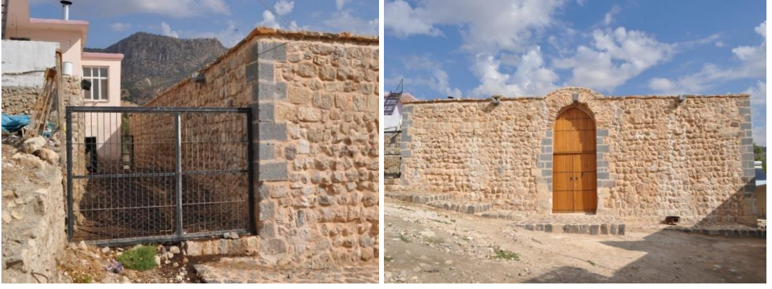
Şekil 4.11. Karakaya Hanının restorasyon sonrası dış cephe görünümü [79].
