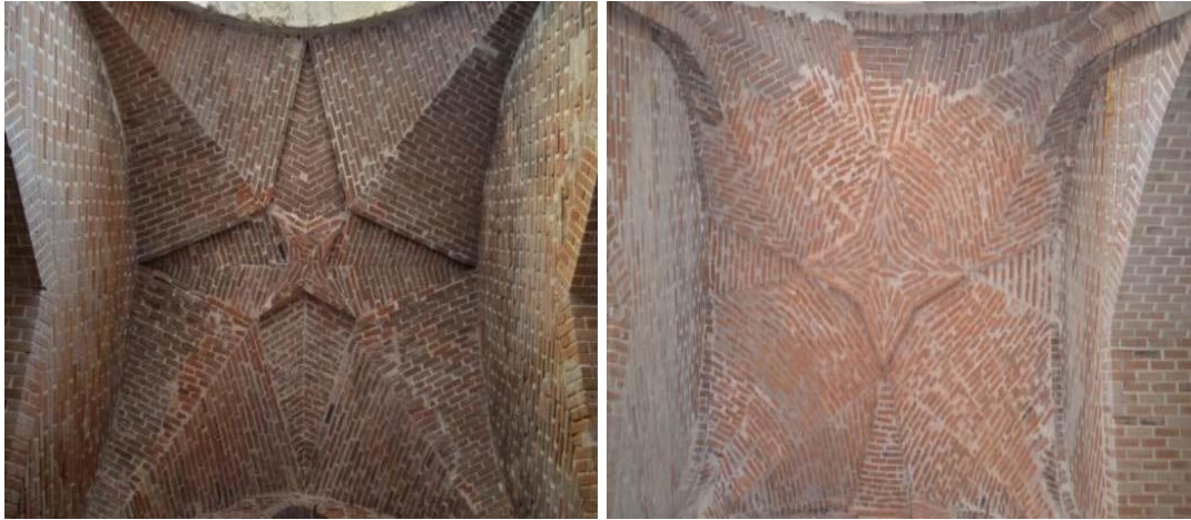
Şekil 4.10. Tonoz tuğlalarının hatalı döşendiği a) 23 numaralı oda tavanı [78] b) 27 numaralı oda tavanı [78].
