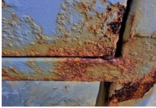
Şekil 1.5. Genel korozyon [24].
