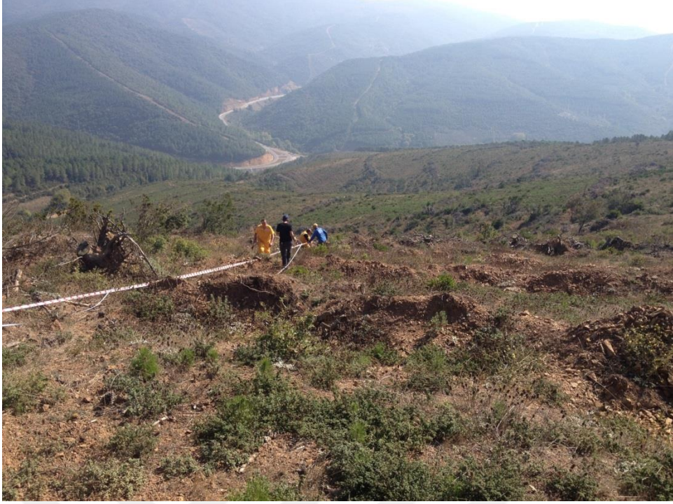
Şekil 2.17. Dozerle tam alanda örtü temizliği ve seki teras şeklinde toprak işleme yapılan yerlerde deneme parsellerinin oluşturulmasından görünüm.
