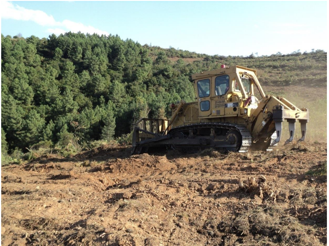
Şekil 2.8. Caterpillar D7 Dozer ile tam alanda üçlü ripperle alt toprak işleme.
