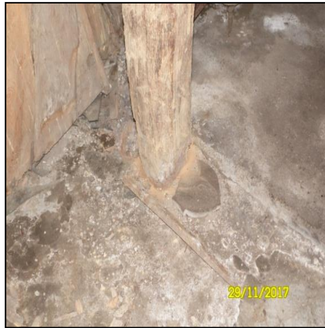
Şekil 4.167. Düşey taşıyıcı ahşap elemanlar.
