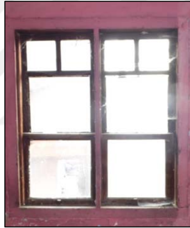
Şekil 4.209. Giyotin tipi oda penceresi.
