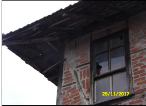
Şekil 4.221. Ahşap kırma çatı.
