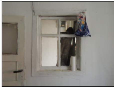
Şekil 4.45. Zemin kat iç pencere örneği.
