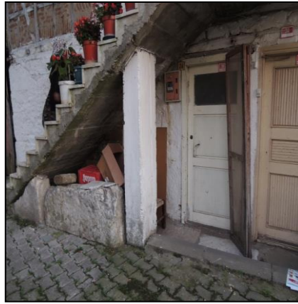
Şekil 4.35. Birinci kata çıkan tek kollu merdiven.
