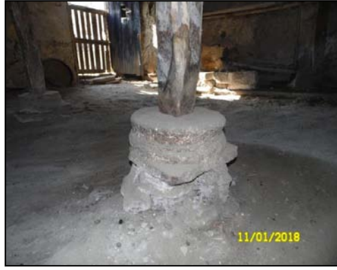
Şekil 4.96. Zemin kat ahşap taşıyıcı eleman ve beton plakalar.
