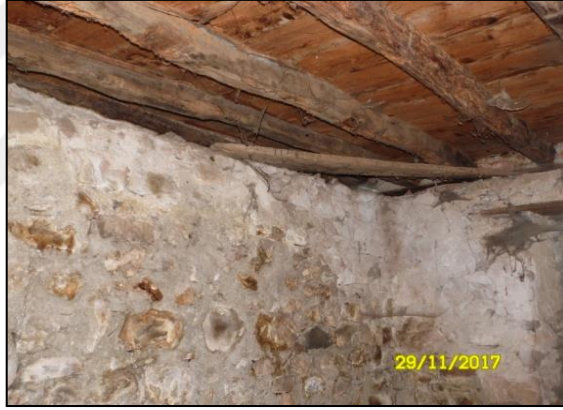
Şekil 4.157. Bodrum kat duvar yapım malzemesi.
