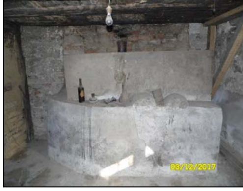
Şekil 4.301. Özgün beton banyo.
