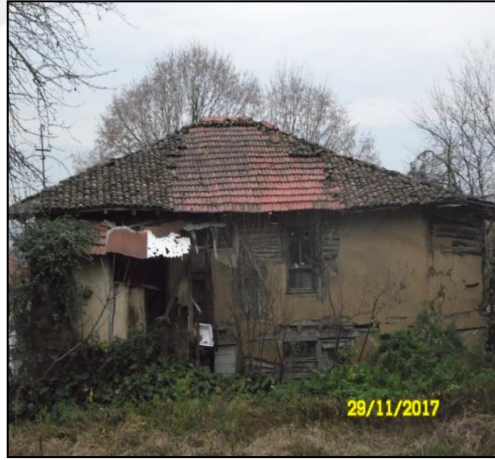
Şekil 4.243. 11 No.lu ev batı cephesi.
