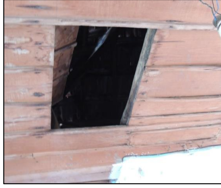
Şekil 4.26. İkinci kat çatı çıkış kapağı.
