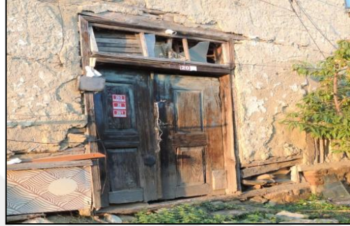
Şekil 4.178. Bodrum kat ahşap giriş kapısı.
