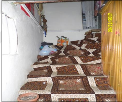
Şekil 4.186. Birinci kat yarı döner ahşap merdiveni.
