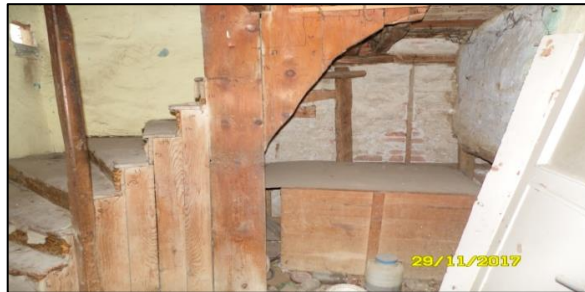
Şekil 4.226. Zemin kat yarım döner ahşap merdivenleri.
