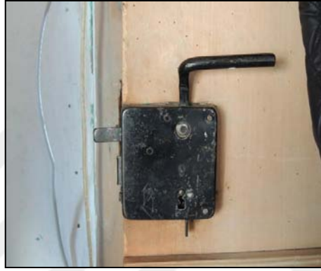
Şekil 4.22. Oda kapısı, özgün kilit örneği.
