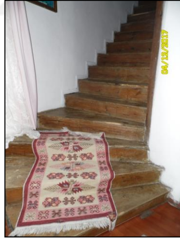
řekil 4.134. Zemin kat merdivenleri.
