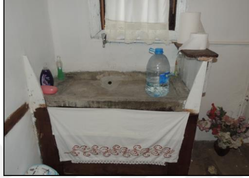
řekil 4.113. İkinci kat holü beton lavabo.
