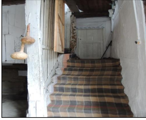
Şekil 4.98. Birinci kat ahşap merdivenleri.
