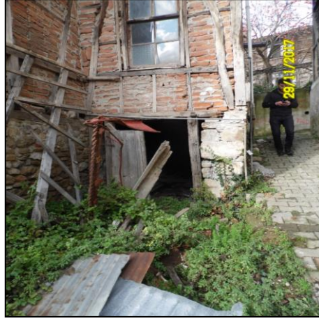
Şekil 4.156. Bodrum kat ahır kapısı.
