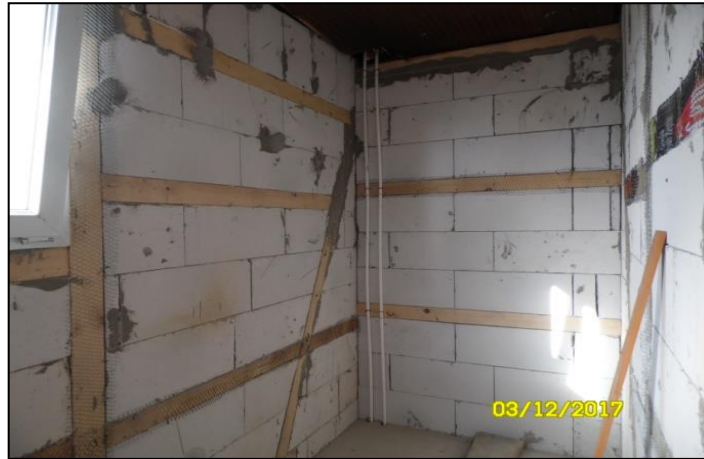
Şekil 4.308. Tadilat halindeki banyo duvarları.
