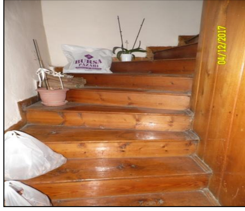
Şekil 4.286. Zemin kat yarı döner ahşap merdivenleri.
