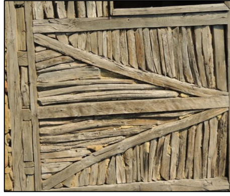
Şekil 4.55. Ahşap çatk1 içerisinde ahşap dolgu yapım tekniđi.
