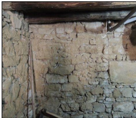
Şekil 4.7. Zemin kat duvarları.
