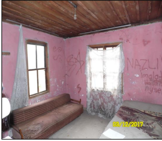
Şekil 4.210. Güneydoğu yönündeki oda.
