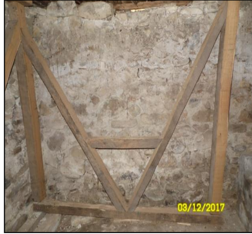
Şekil 4.295. Beton plakaların üzerine oturtulmuş ahşap taşıyıcı elemanlar.
