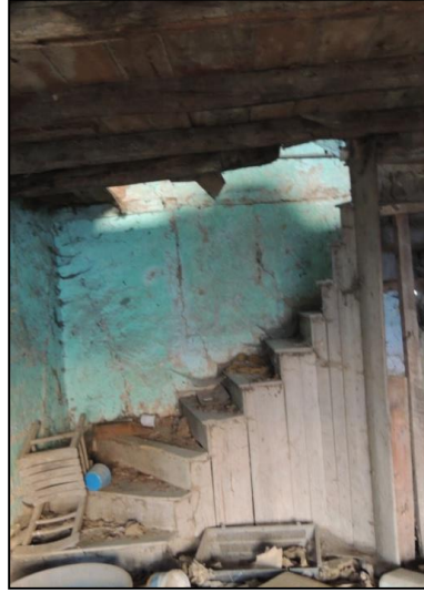
Şekil 4.64. Zemin kat merdivenleri.
