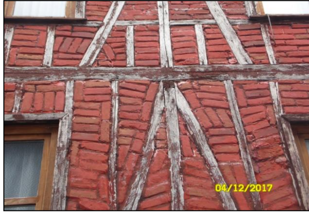
Şekil 4.267. Ahşap çatıklı tuğla dolgu yapım sistemi.
