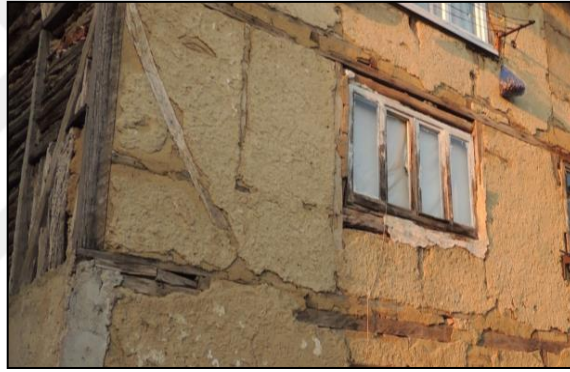
Şekil 4.176. Ahşap taşıyıcı sistem.
