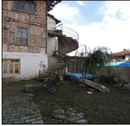
Şekil 4.32. 2 No.lu ev betonarme tam döner merdiven.
