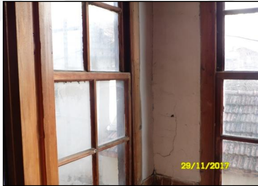
Şekil 4.160. Zemin kat giriş sahanlığı pencereleri.
