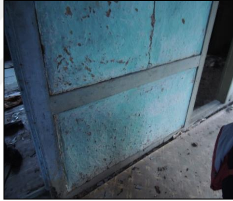
Şekil 4.60. Sofada yer alan hatıl.
