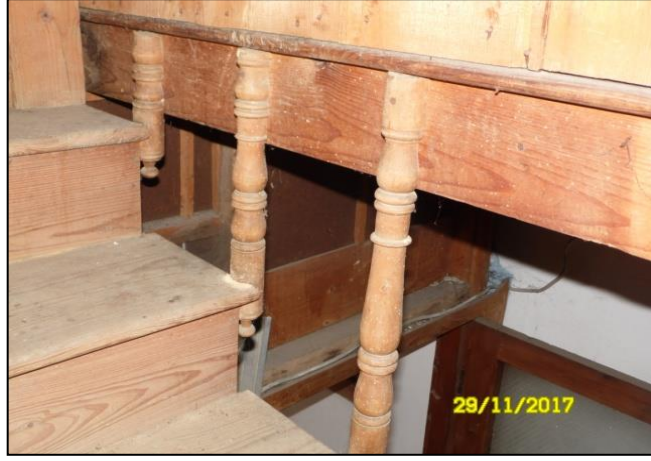
Şekil 4.172. Dairesel ahşap merdiven korkulukları.
