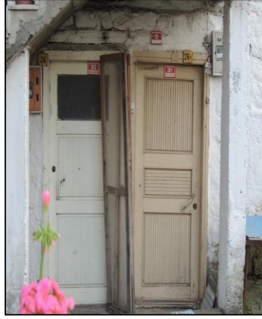
Şekil 4.31. 2 No.lu ev ana giriş kapıları.
