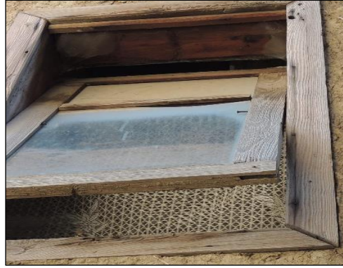
Şekil 4.101. Ahşap tuvalet penceresi.
