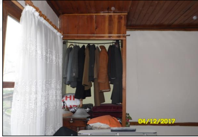
Şekil 4.287. Merdiven boşluğu üzerindeki ahşap dolap.
