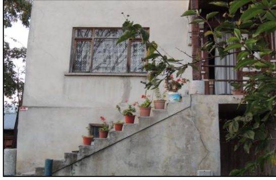
Şekil 4.126. Betonarme zemin kata çıkış merdiveni.
