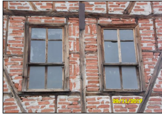
Şekil 4.214. 10 No.lu eve ait ahşap pencere örnekleri.
