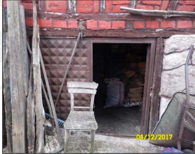
Şekil 4.271. Bodrum kat giriş kapısı.
