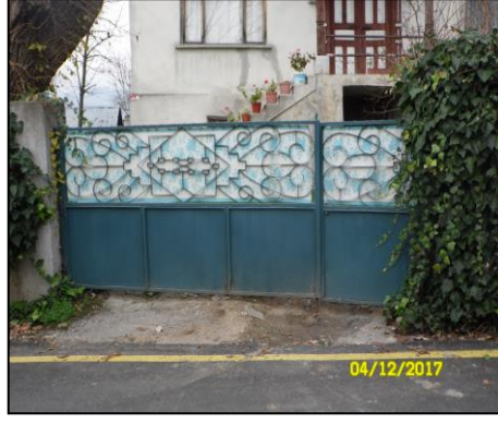
Şekil 4.118. Güney cephesi ana giriş kapısı.
