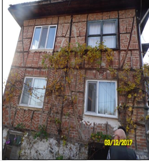
Şekil 4.307. Çift kanatlı PVC (Polivinil Klorür) pencereler.
