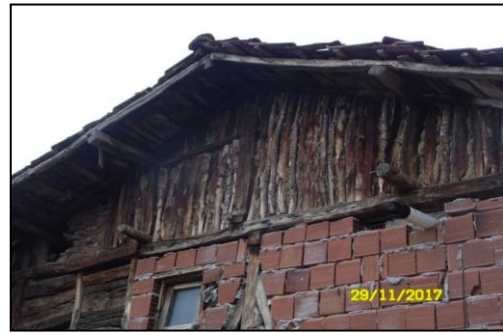
Şekil 4.180. 8 No.lu Ev ahşap çatı strüktürü.
