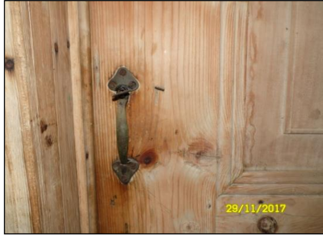
Şekil 4.229. Metal kapı kolu (zemberek).
