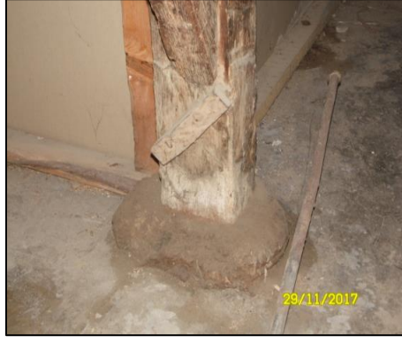
Şekil 4.224. Beton plakalar üzerine oturtulmuş düşey taşıyıcı ahşap eleman.
