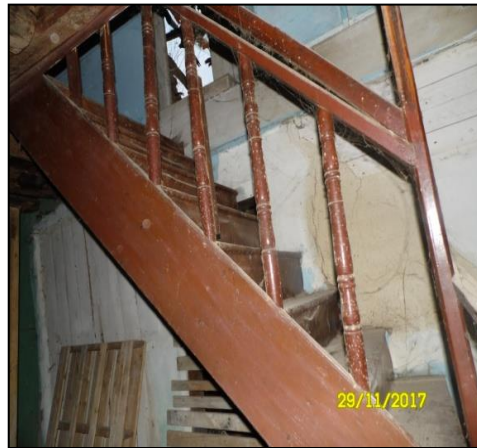
Şekil 4.260. Zemin kat ahşap merdivenleri ve korkulukları.
