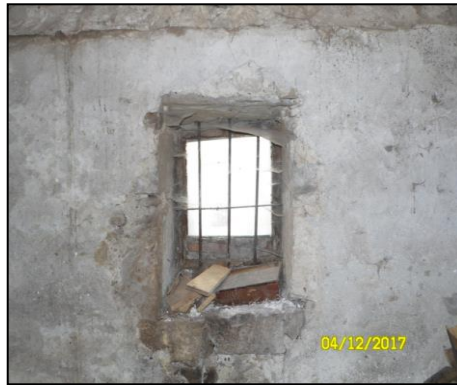
Şekil 4.125. Bodrum kat ahşap pencere örneği.
