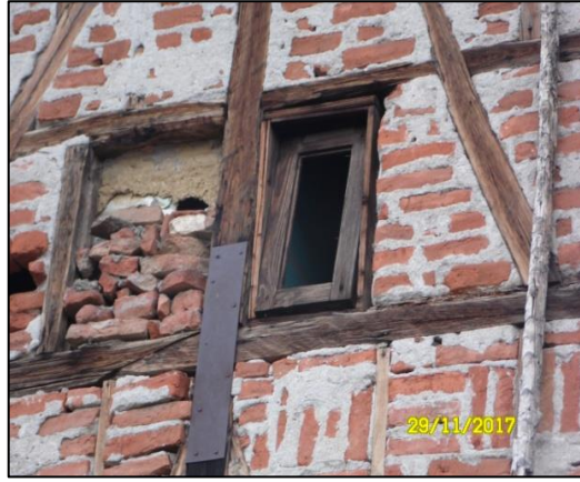
Şekil 4.227. Zemin kat pencere örneği.
