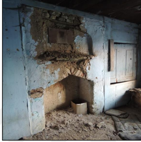
Şekil 4.62. 3 No.lu ev geleneksel ocak ve dolaplar.
