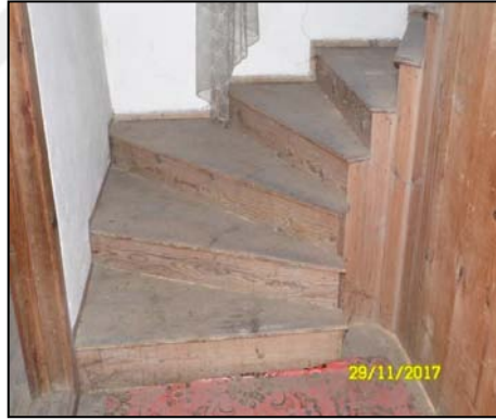
Şekil 4.171. Birinci kat yarı döner ahşap merdivenleri.
