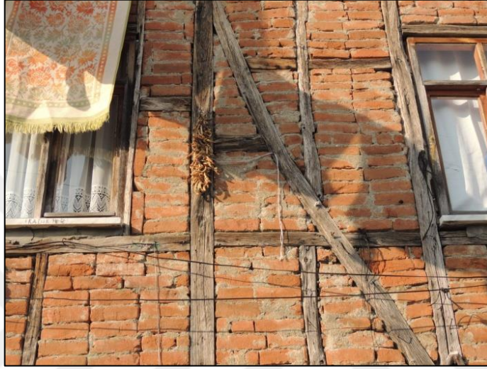
Şekil 4.8. Ahşap çatıklı tuğla dolgulu duvar yapım sistemi.
