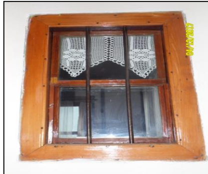
Şekil 4.281. Rüzgârlığa açılan iç pencere.
