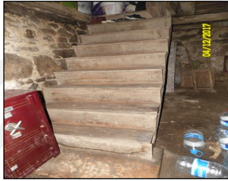
Şekil 4.124. Bodrum kat ahşap merdivenleri.
