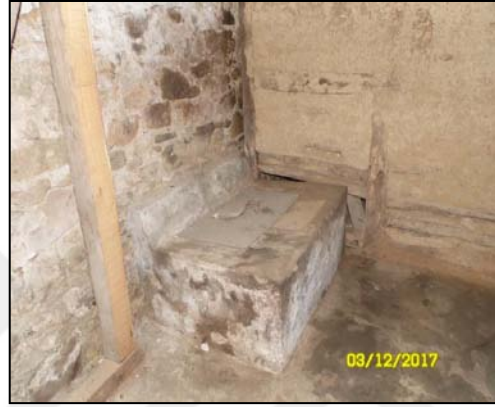
Şekil 4.302. Özgün beton tuvalet.
