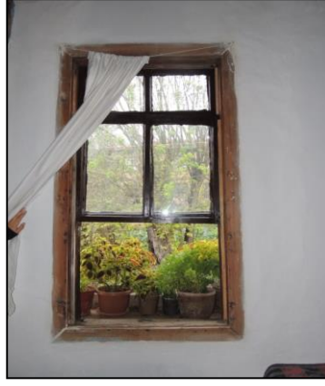
Şekil 4.110. Giyotin tipi oda penceresi.
