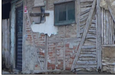
Şekil 4.79. Birinci kat giriş cephesi.
