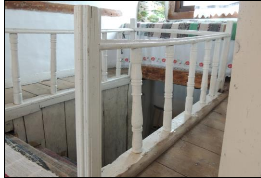
Şekil 4.107. İkinci kat ahşap merdivenleri ve korkulukları.
