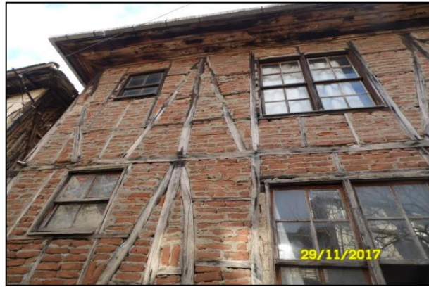
Şekil 4.158. Ahşap çatıklı tuğla duvar yapım sistemi.
