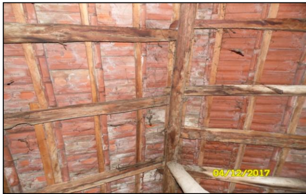
Şekil 4.269. Ahşap oturtma çatı konstrüksiyonu.
