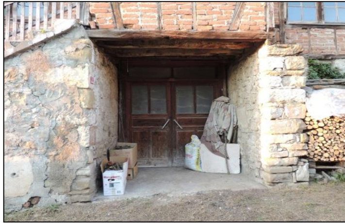
Şekil 4.155. Bodrum kat giriş kapısı.
