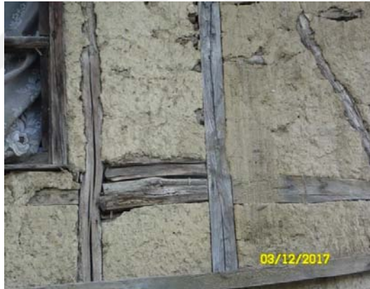
Şekil 4.195. 9 No.lu ev duvar yapım sistemi.
