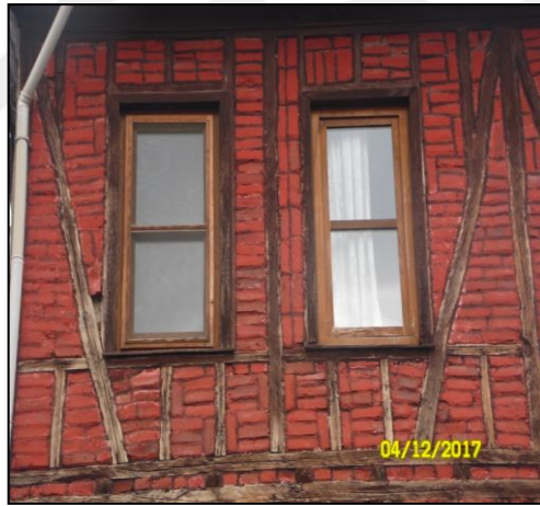
Şekil 4.266. Ahşap pencereler ve metal aksamları.
