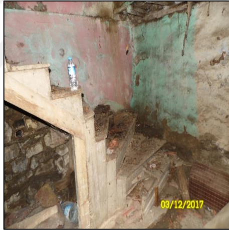
Şekil 4.200. Zemin kat yarım döner ahşap merdivenleri.
