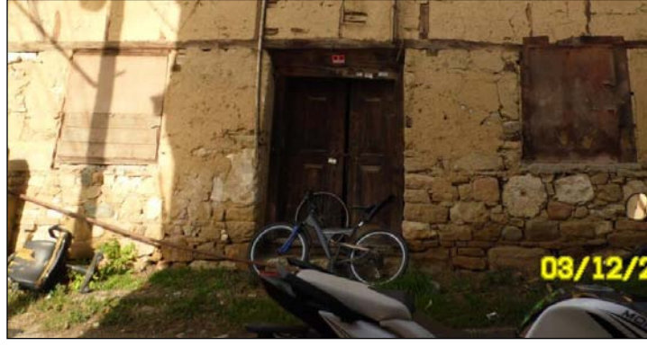
Şekil 4.201. Zemin kat sofası pencereleri.
