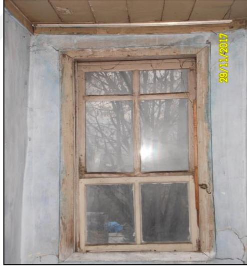
Şekil 4.245. Giyotin tipi pencere örneği.
