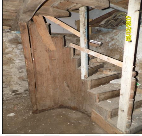
Şekil 4.299. Bodrum kat ahşap merdiveni ve korkulukları.
