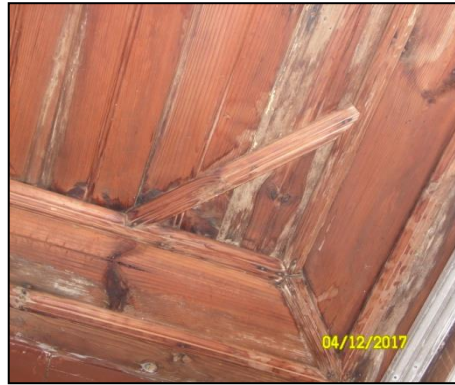
Şekil 4.141. Birinci kat tekne tavan ve köşe birleşim detayı.
