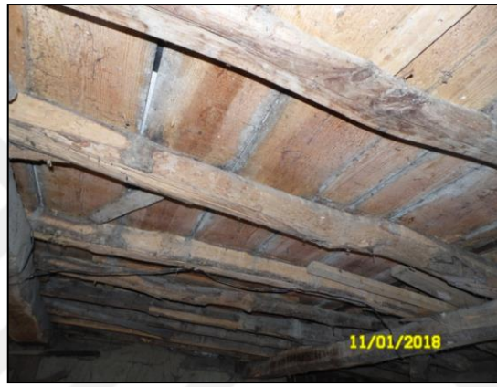
Şekil 4.95. Zemin kat tavan örneği.
