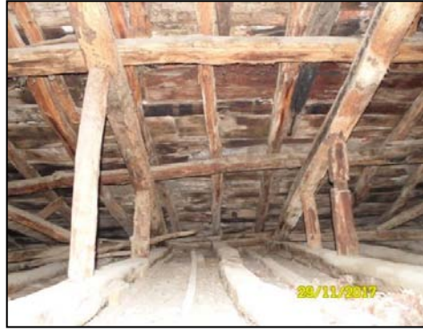
Şekil 4.248. Ahşap çatı strüktürü.
