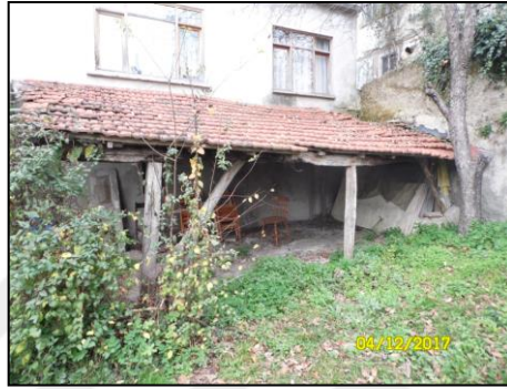
Şekil 4.119. Sundurma çatı ile kapatılmış yarı açık depolama alanı.
