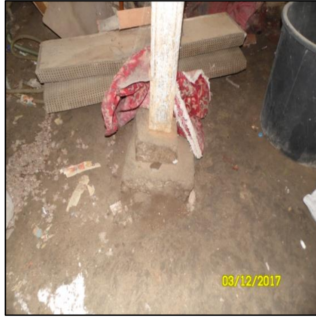
Şekil 4.199. Beton plakalar üzerine oturtulmuş düşey taşıyıcı ahşap elemanlar.
