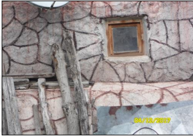
Şekil 4.268. Moloz taş görünümlü bodrum kat duvarları.
