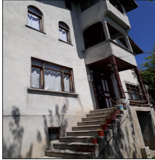
Şekil 4.127. Ahşap taşıyıcı elemanlarla desteklenen cumba.
