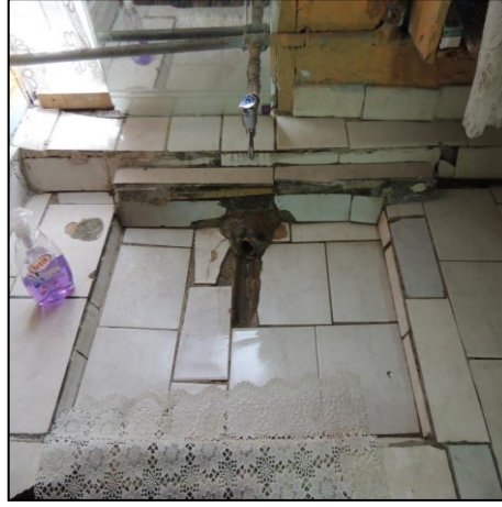
Şekil 4.100. Seramik kaplı beton lavabo.
