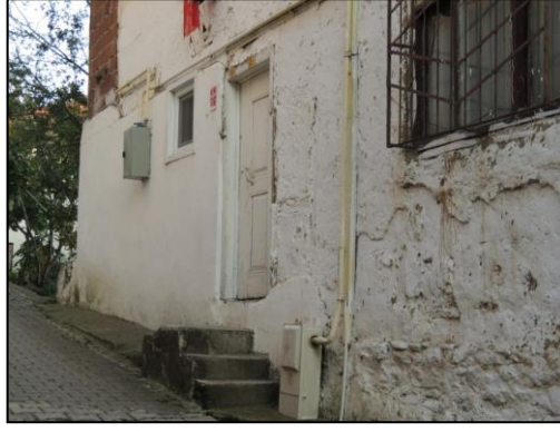
Şekil 4.177. Kuzey yönü zemin kat giriş merdivenleri.
