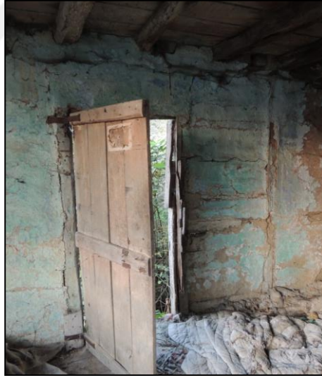
Şekil 4.58. Zemin kat giriş kapısı.
