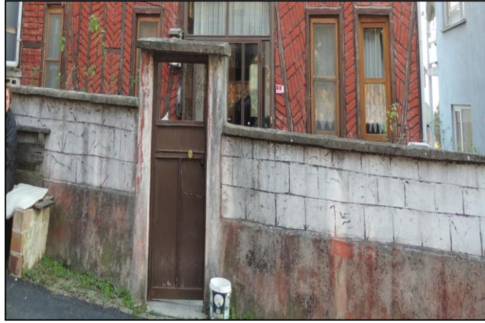
Şekil 4.265. Metal bahçe kapısı.
