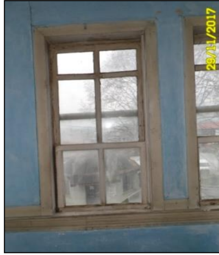
Şekil 4.255. Giyotin tipi pencere örneği.
