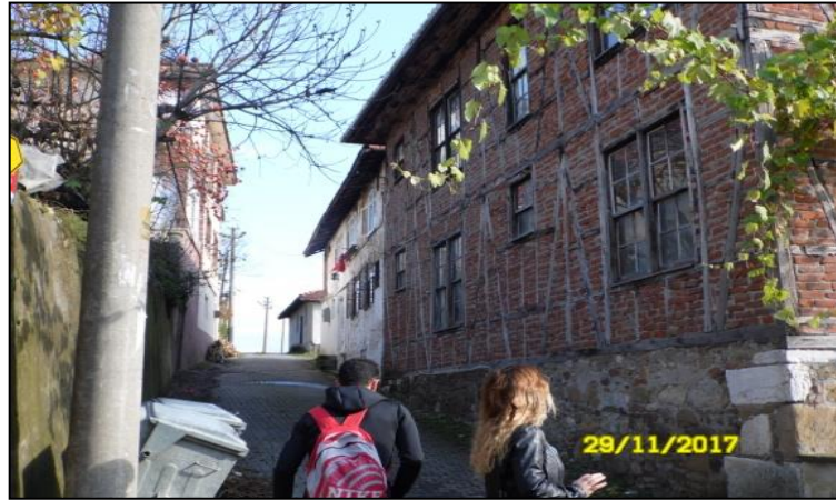
Şekil 4.151. 7 No.lu ev kuzey yönü cephesi.
