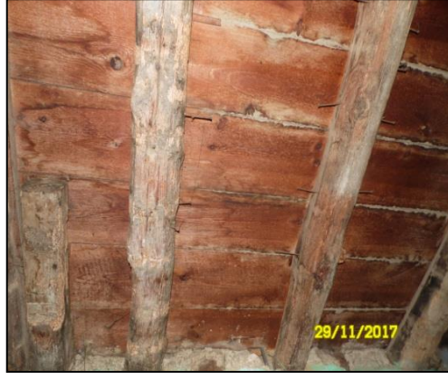
Şekil 4.246. Zemin kat tavan örneği.
