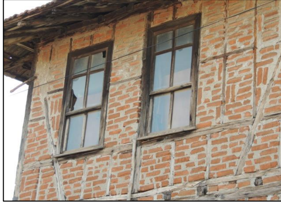
Şekil 4.219. Tuğla dolgulu hımiş yapım tekniği.
