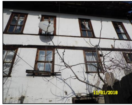
Şekil 4.91. 5 No.lu ev güney cephesi.
