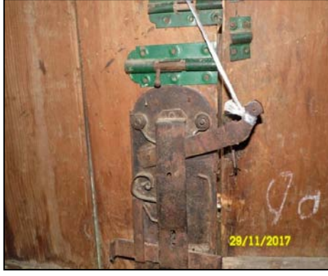
Şekil 4.185. Bodrum kat ana giriş kapısı özgün kilit örneği.
