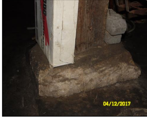
Şekil 4.277. Beton plakalar üzerine oturtulmuş düşey taşıyıcı ahşap elemanlar.
