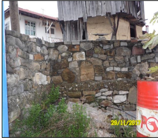
Şekil 4.216. Kuzeydoğu cephesi bahçe duvarı.
