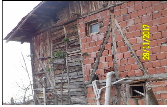
Şekil 4.187. Tuğla duvar örgüsü ile duvar onarımı.
