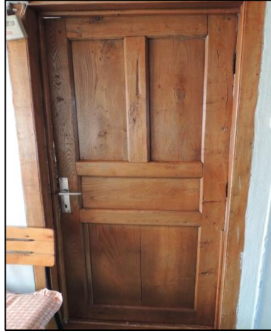
Şekil 4.3. Zemin kat oda kapısı
