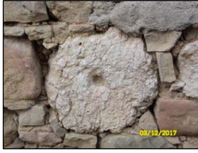
Şekil 4.196. Dikdörtgen ve silindirik kesme taşlar.
