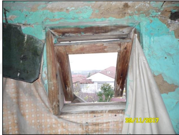
Şekil 4.237. Vasistas açılan ahşap mutfak penceresi.
