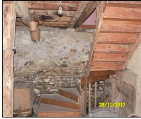
Şekil 4.165. Bodrum kat yarı döner ahşap merdivenleri.
