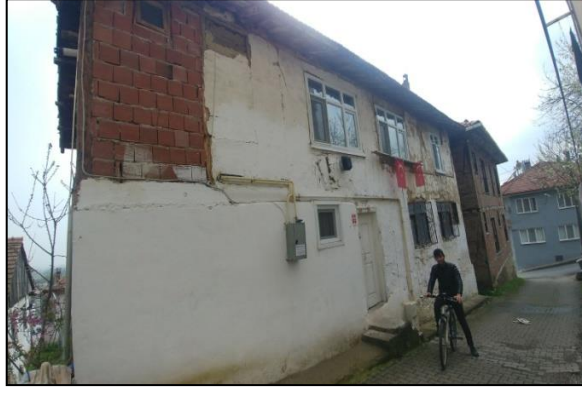
Şekil 4.175. 8 No.lu ev kuzey cephesi.
