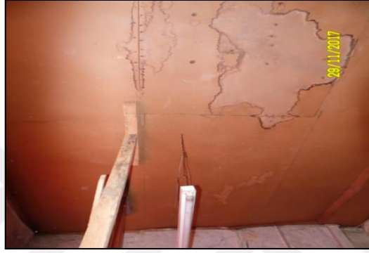
Şekil 4.72. 4 No.lu ev zemin kat tavanı.
