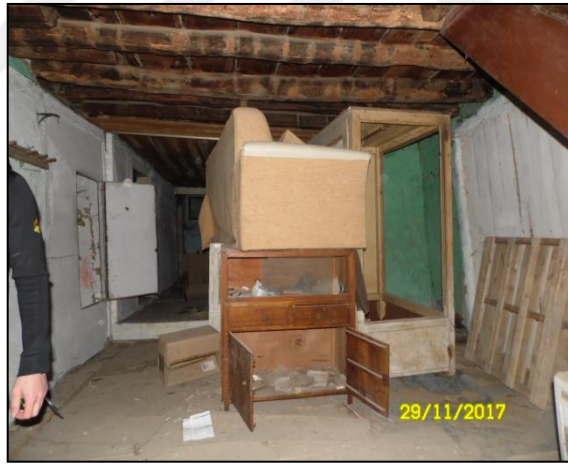
Şekil 4.252. Zemin kat sofası.
