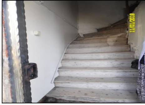
Şekil 4.80. Birinci kat ahşap merdivenleri ve ahşap korkuluklar.
