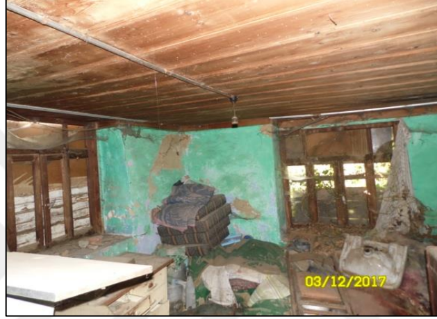
Şekil 4.202. Zemin kat kuzey yönündeki oda.
