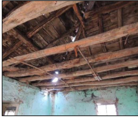
Şekil 4.54. 3 No.lu ev ahşap çatı strüktürü.
