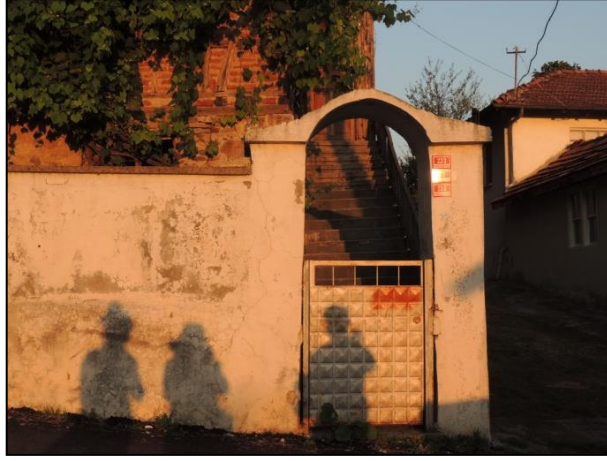
Şekil 4.152. Metal bahçe kapısı.
