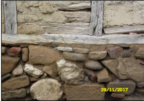
Şekil 4.179. Temel ve duvar yapım malzemeleri.
