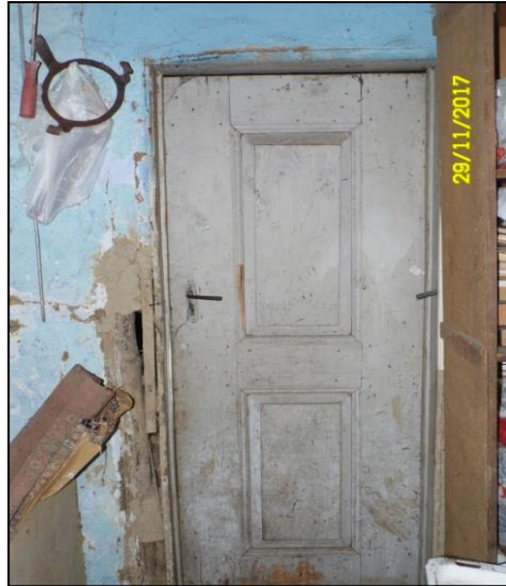
Şekil 4.184. Bodrum kat oda kapısı örneği.
