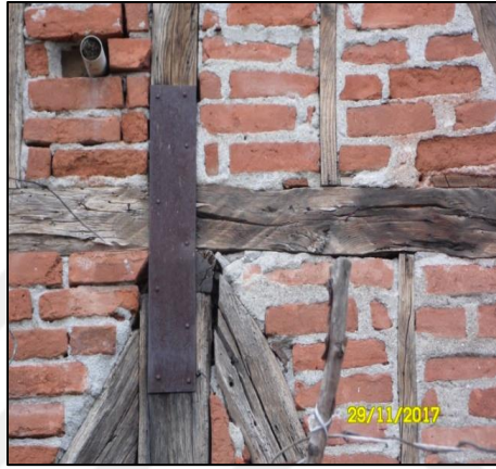
Şekil 4.220. Taşıyıcı sistemin düğüm noktalarındaki metal elemanlar.
