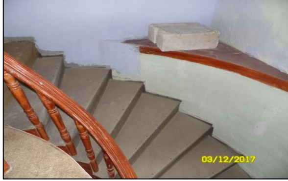
Şekil 4.304. Zemin kat yarı döner ahşap merdivenleri ve korkulukları.
