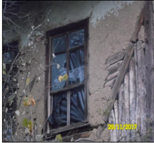
Şekil 4.247. Ahşap çatklı ahşap dolgu yapım sistemi.
