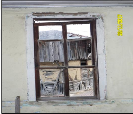
Şekil 4.234. Giyotin pencere örneği.
