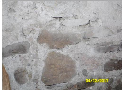
Şekil 4.276. Bodrum kat moloz taş duvarları.
