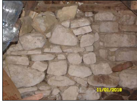
Şekil 4.92. 5 No.lu evi temel yapım malzemesi.
