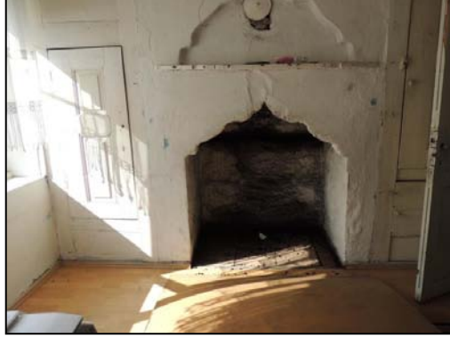
Şekil 4.41. 2 No.lu ev geleneksel ocak ve dolaplar.
