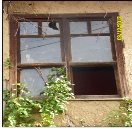
Şekil 4.194. Giyotin tipi pencere örneği.
