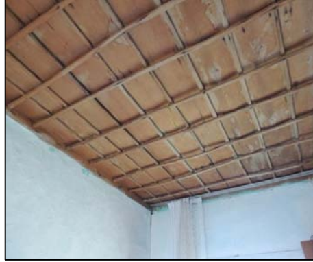
Şekil 4.24. İkinci kat çıtakari tavan örneği.
