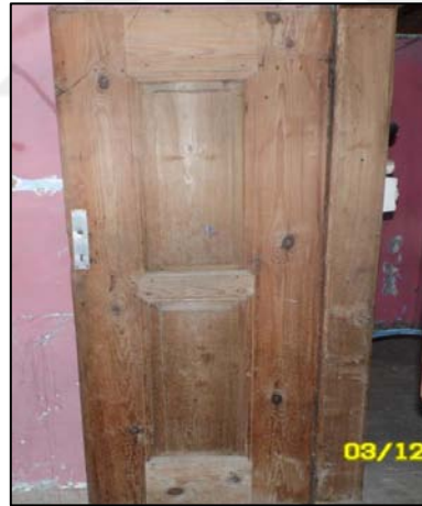
Şekil 4.207. Ahşap oda kapısı örneği.
