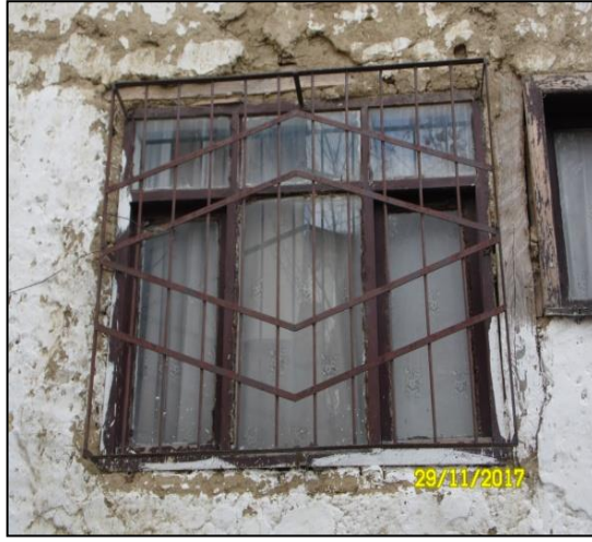
Şekil 4.191. Zemin kat metal pencere kafesi.
