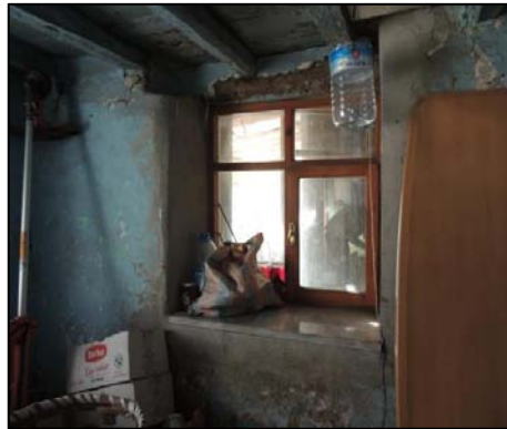
Şekil 4.16. Zemin kat pencere örneği.
