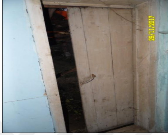
Şekil 4.261. Ahşap sürgülü kapı.
