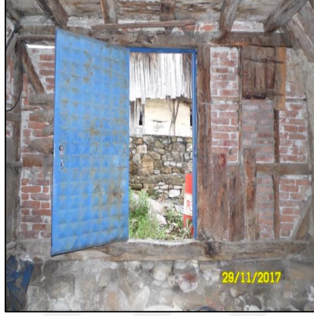
Şekil 4.215. Zemin kat doğu yönündeki ana giriş kapısı.
