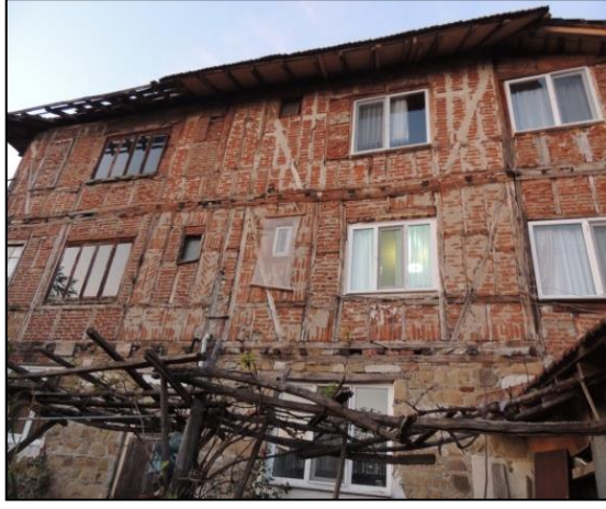
Şekil 4.36. Ahşap çatkılı tuğla dolgu yapım sistemi.
