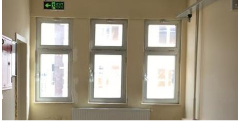
Şekil 6.38. Camlarda koruyucu filmlerin olmaması.
