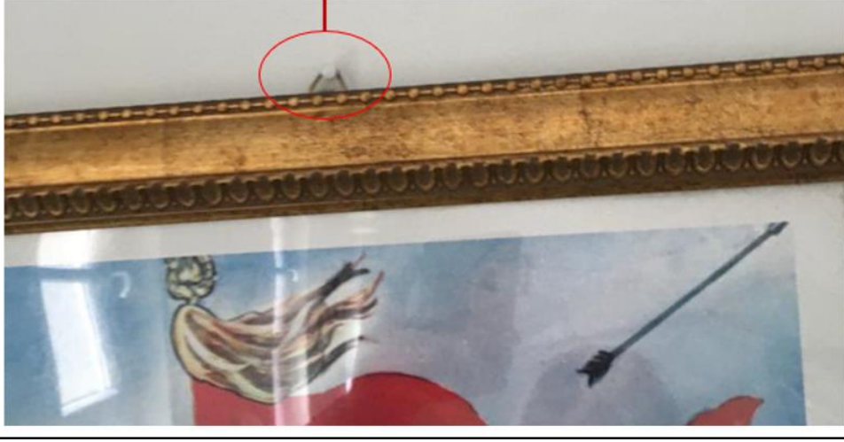
Şekil 6.26. Çerçeve ve panoların sabitlenmesi.
