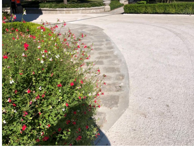
Şekil 2.13. III. Avlu 'ya ait farklı malzemelerle yapılan yer döşemeleri.
