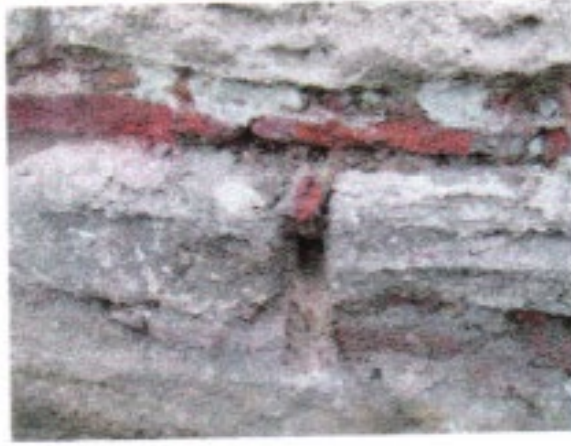
Şekil 2.47. Mutfaklar bölümünün zemin kotuna yakın duvar görünüşü.
