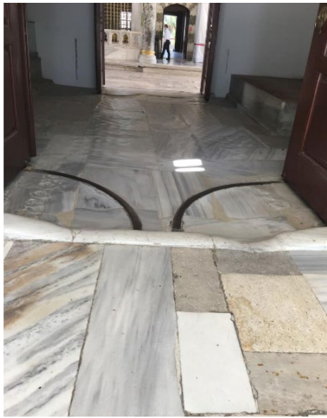
Şekil 2.20. Babbüssade kapısının girişine ait yer döşemesi.
