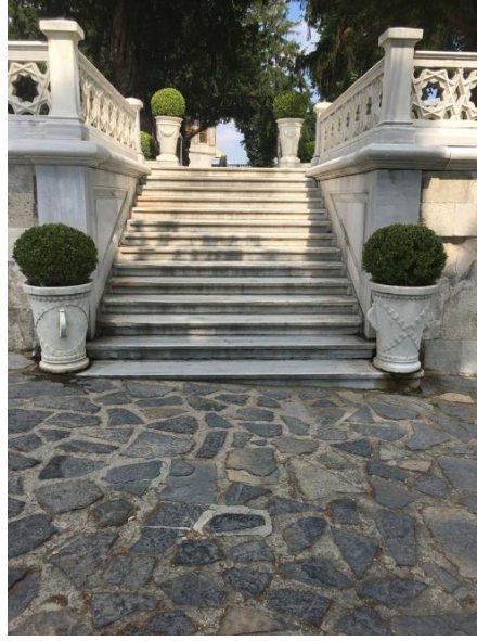
Şekil 2.17. IV. Avlu'ya ait kayrak taşı yer döşemesi.
