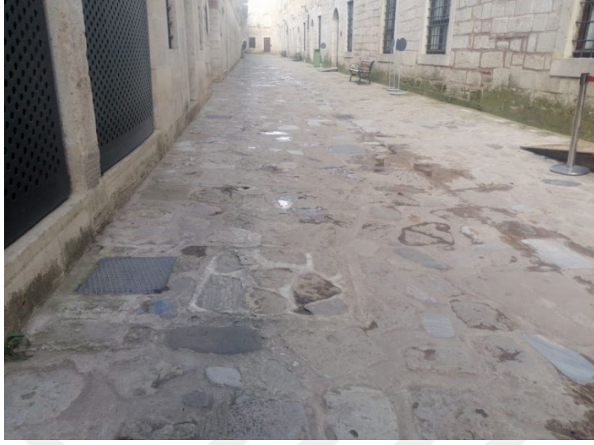
Şekil 2.11. II. Avlu'nun mutfaklar bölümünün divan yoluna ait küfeki taşı ve farklı malzemelerle kaplanan yer döşemesi örneği.
