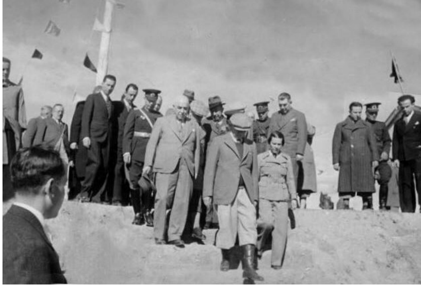
Görsel 25. Atatürk'ün Sivas Gezisi ve Cer Atölyesi İnşaatı İncelemesi, 1937. (Faruk Aburşu Fotoğraf Koleksiyonu).
