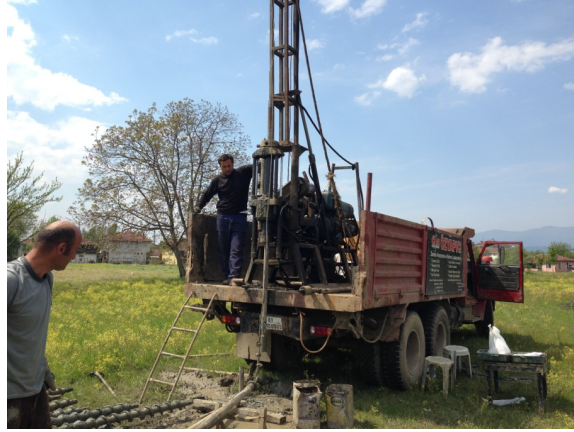
Şekil 3. Arazide SPT Deneyi Sondaj Çalışması
