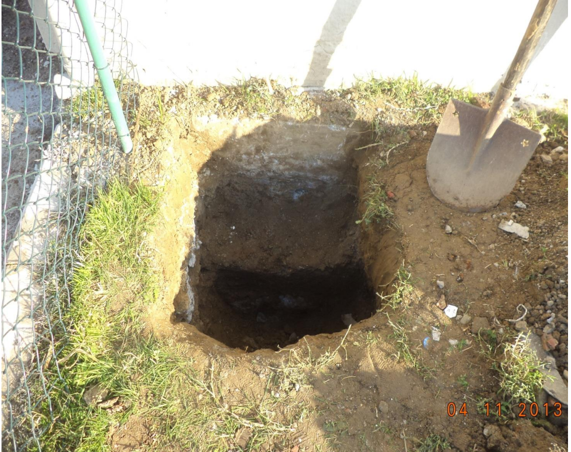
Şekil 2.4. Bina temel sistemi tespit çalışmaları.
