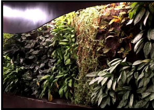
Şekil 6. Skyteam Lounge dikey bahçesindeki susuzluk belirtileri
